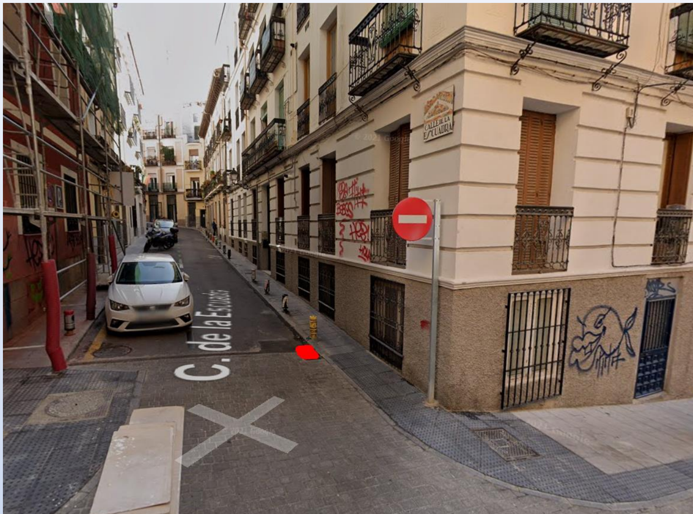
Rejilla de saneamiento (en rojo) de tamaño insuficiente
