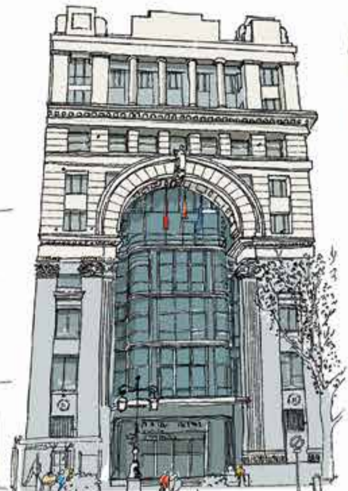
5 BANCO DE ESPAÑA. 1919. CALLE DE ALFARO 4
