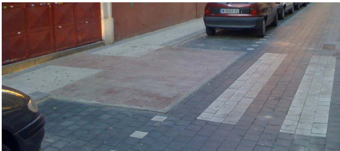
Imagen 23. Paso de peatones en aceras estrechas
