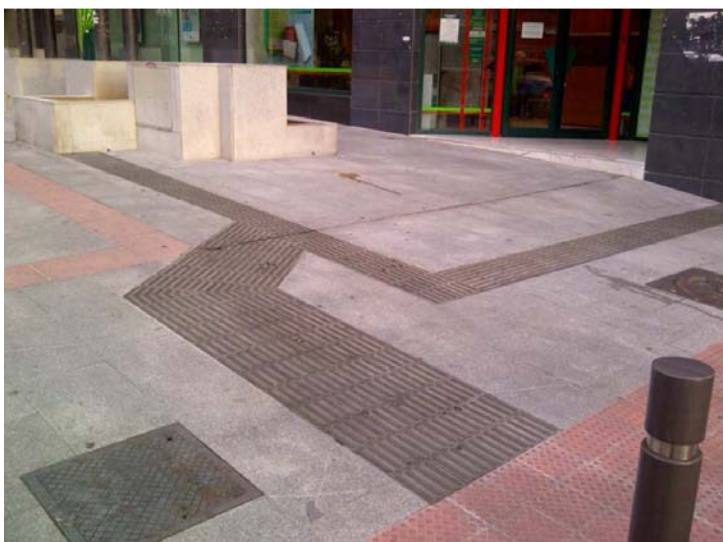
Imagen 11. Uso de pavimentos auxiliares para marcar la "alineación virtual" de fachadas
