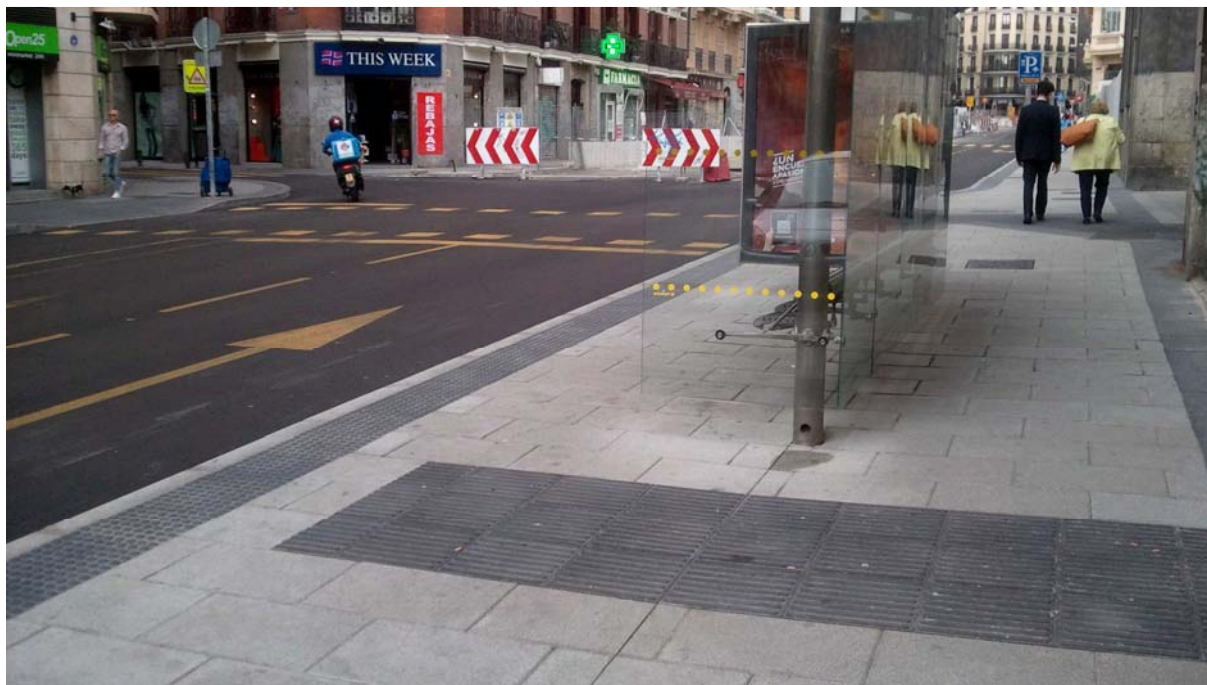
Imagen 10. Uso de pavimentos tacto visuales en la señalización de una marquesina de autobús urbano
