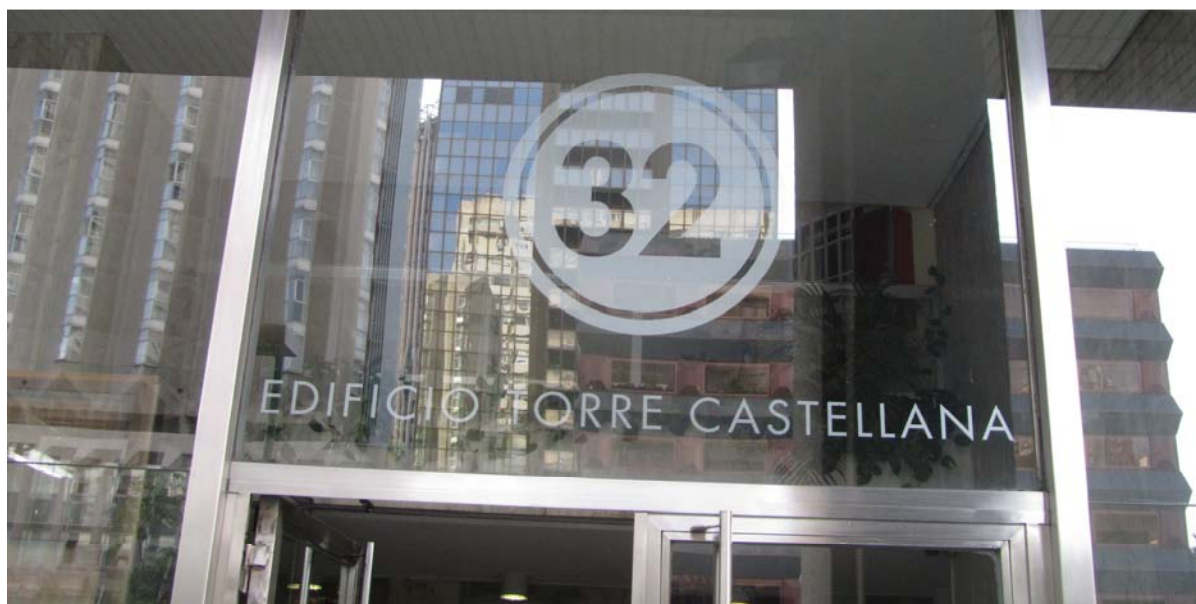
Imagen 05. Nombre de la calle y números en los edificios con un tamaño de letra y ubicación correctos, pero con mal contraste cromático y elección del material al producir deslumbramientos.
