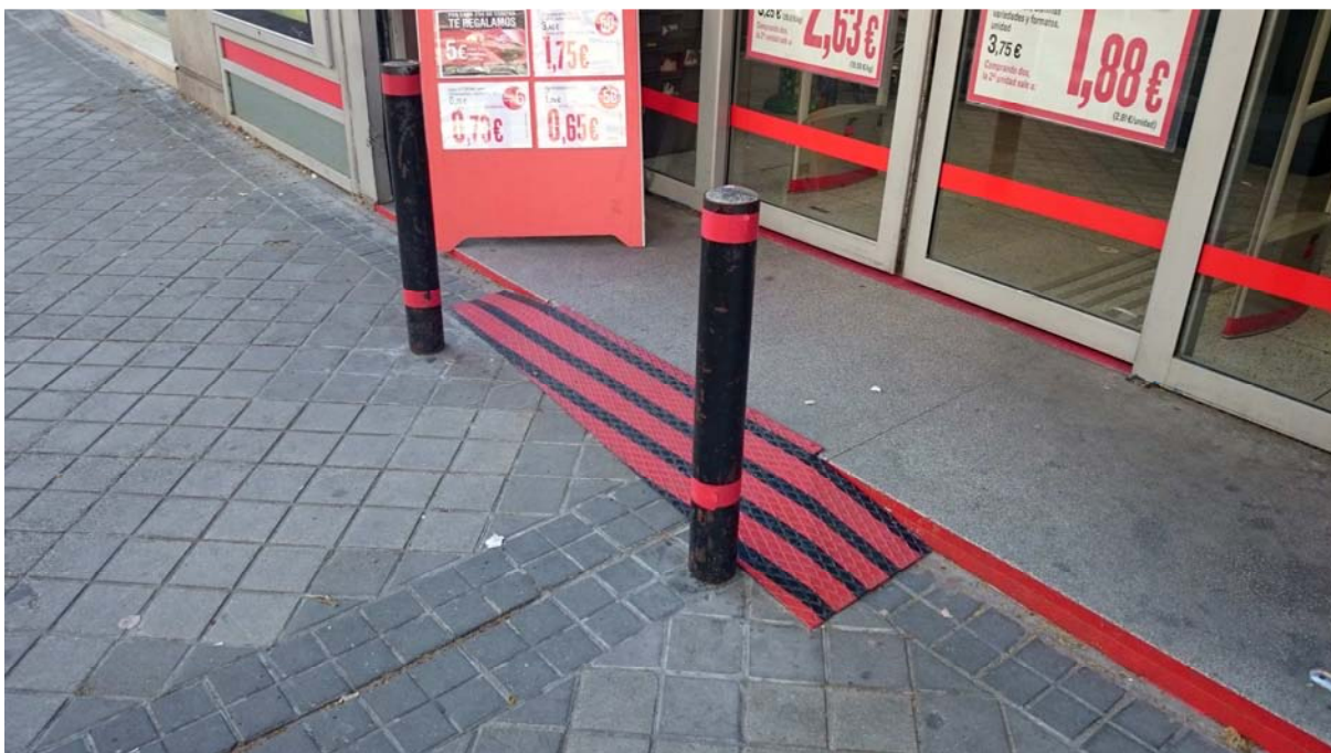
Imagen 02. Rampa removible de acceso a comercio en la calle de Clara del Rey. Cuando se prevea generar un escalón lateral, como sucede en la imagen anterior, una solución para eliminarlo es generar una rampa de tres planos inclinados que, en ningún caso, debe constituir un obstáculo en el IPA. En este caso se complementa su señalización con dos bolardos de color contrastado.
