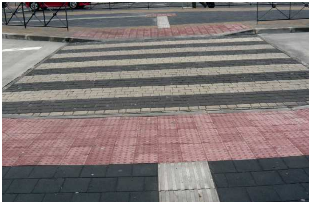
Imagen 19. Área intermodal de Canillejas Al tratarse de un área intermodal en la que se establecen pavimentos en bandas de encaminamiento entre distintas áreas, las bandas de detección y dirección son sustituidas por los mencionados encaminamientos.
