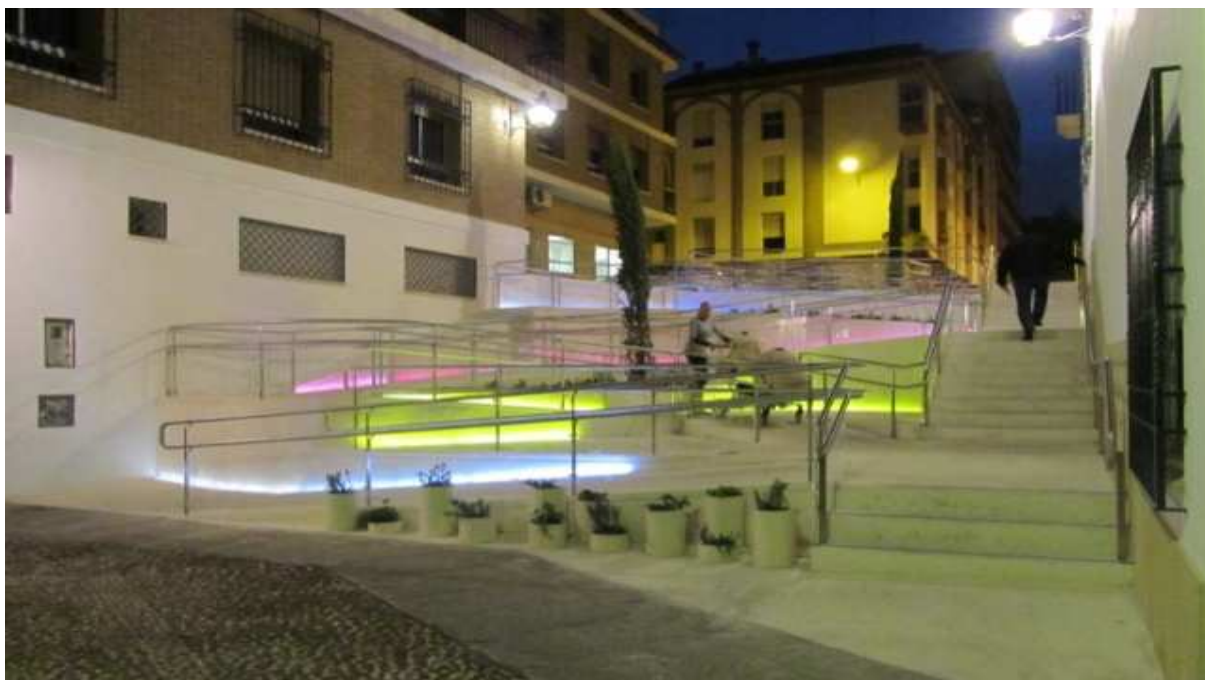
Imagen 09. Iluminación de carácter general adosada a las fachadas de los edificios, unida a iluminación ornamental y de resalto en la rampa que permite orientar a personas con discapacidad cognitiva. Córdoba.
