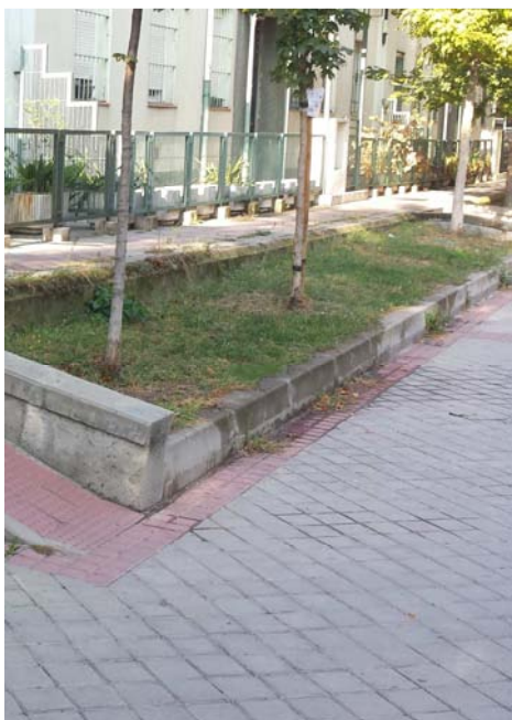
Imagen 11. Mientras que en el parterre de la izquierda el bordillo empleado es fácilmente detectable por parte de usuarios de bastón blanco, en el de la derecha se genera una situación de incertidumbre al no identificarse correctamente el límite entre acera y ajardinamiento.
