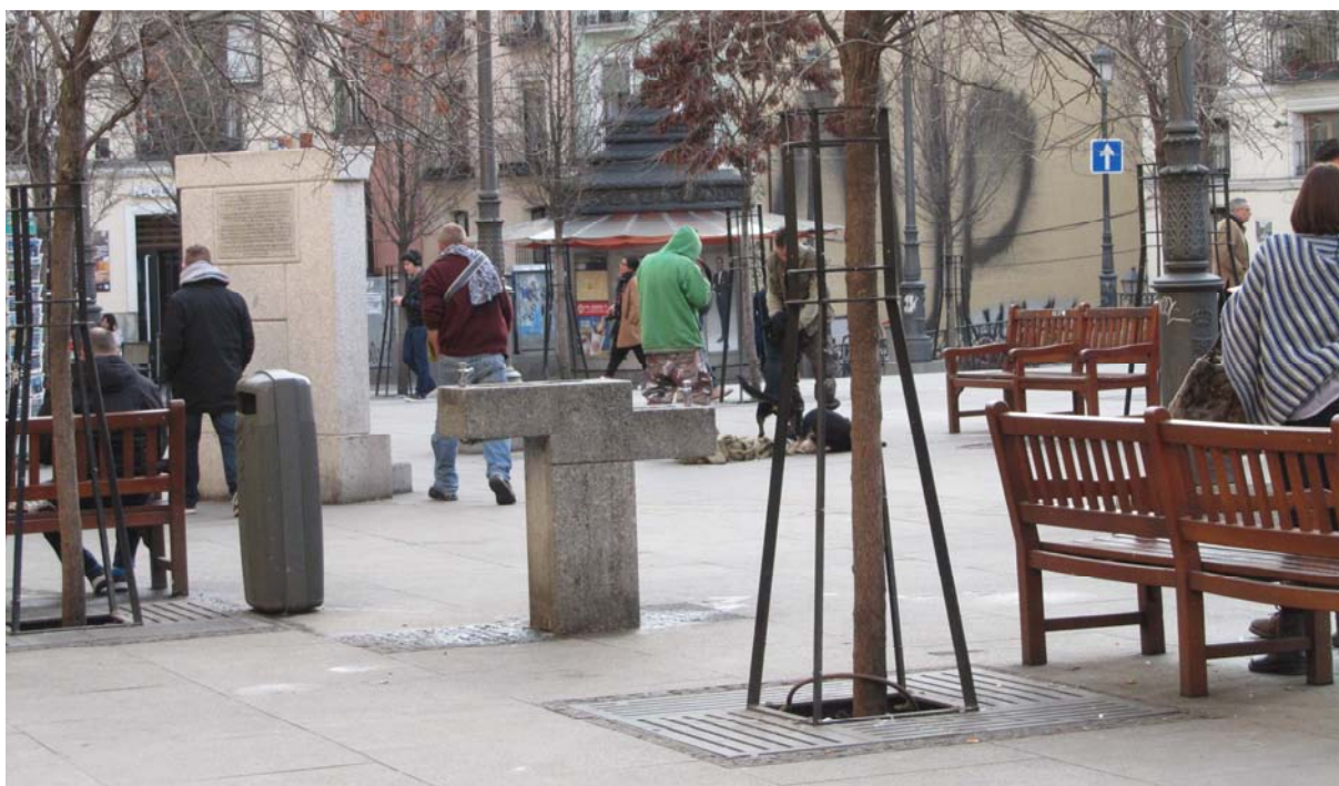
Imagen 16. Alcorques ubicados dentro del itinerario peatonal con el modelo anterior de rejilla de la imagen 17
