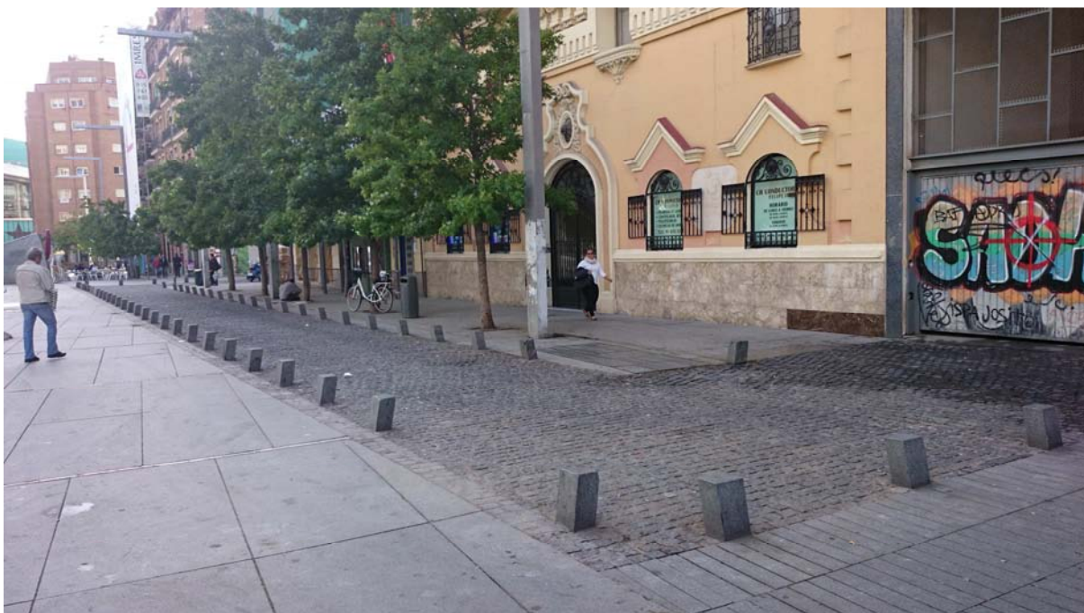
Imagen 12. Plaza de Salvador Dalí. Distinción de la zona de paso compartida con los vehículos a través de la textura y cromatismo del pavimento. Los bolardos, de formato absolutamente inadecuado , obstaculizan la invasión del espacio peatonal por parte de vehículos.
