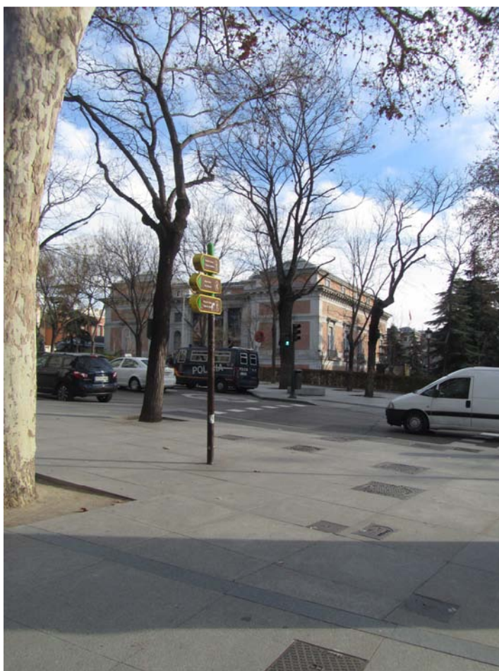
Imagen 18. Tapas de registro enrasadas en el itinerario peatonal accesible
