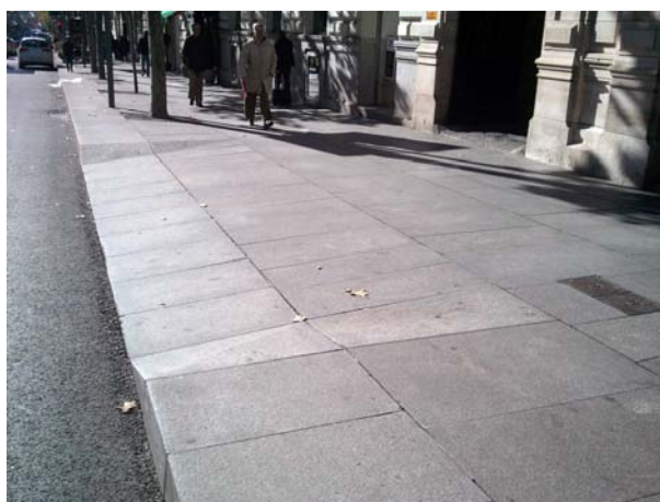
Imágenes 03 y 04. Vados de vehículos con pavimentos de aspecto peatonal.
