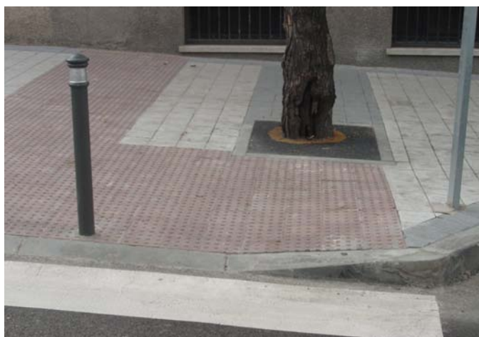
Imagen 02. Formación de vado de peatones en desnivel acera - calzada
