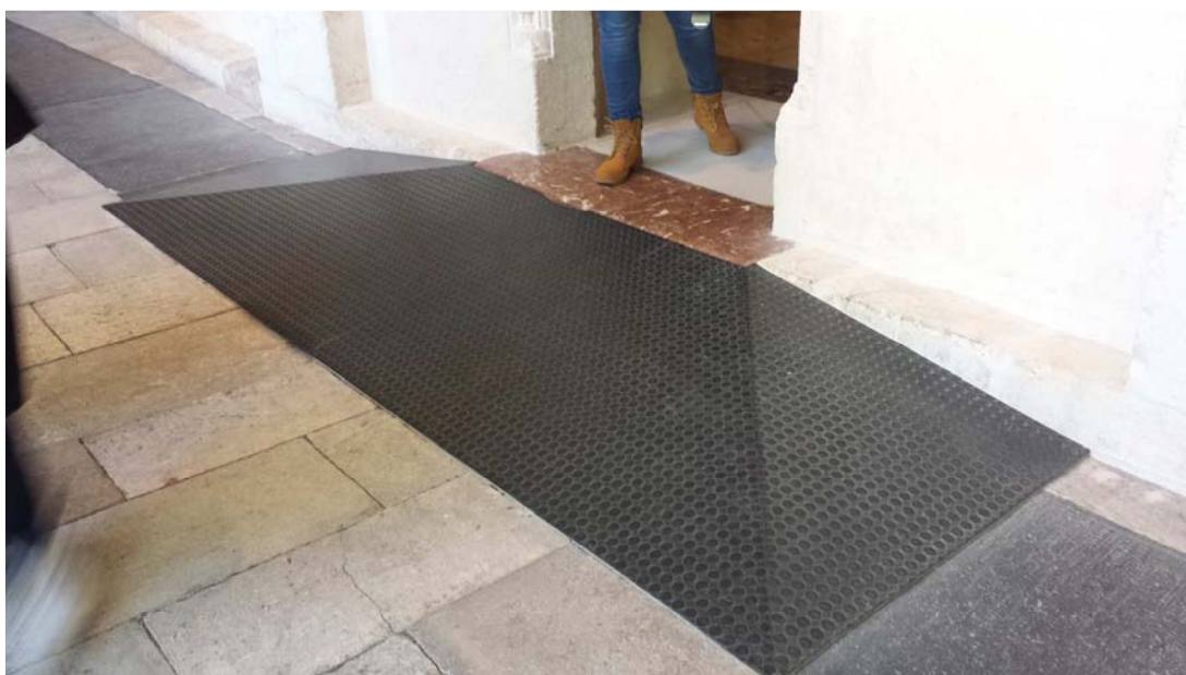
Imagen 12. Rampa temporal de acceso a edificios. En ocasiones el acceso a comercios o locales puede resolverse con elementos temporales en los que el tratamiento del escalón lateral como rampa limita el peligro de tropiezo
