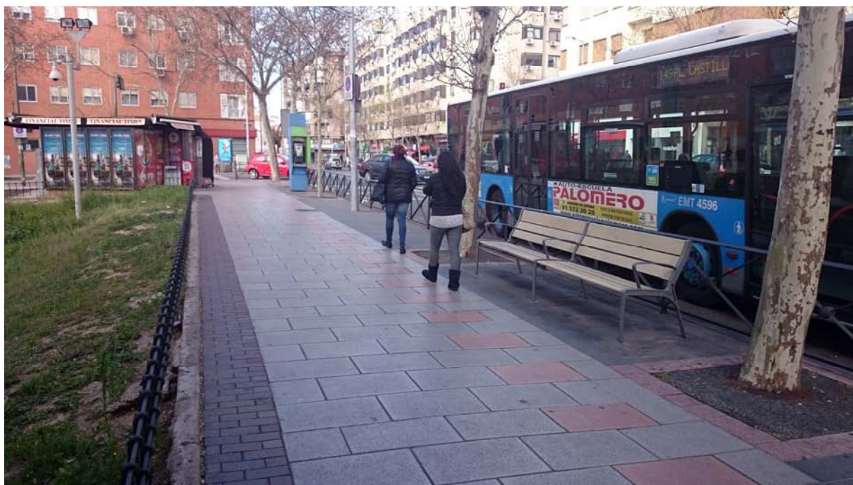
Imagen 01. Vista general de elementos de un itinerario peatonal accesible en la calle de Bravo Murillo
