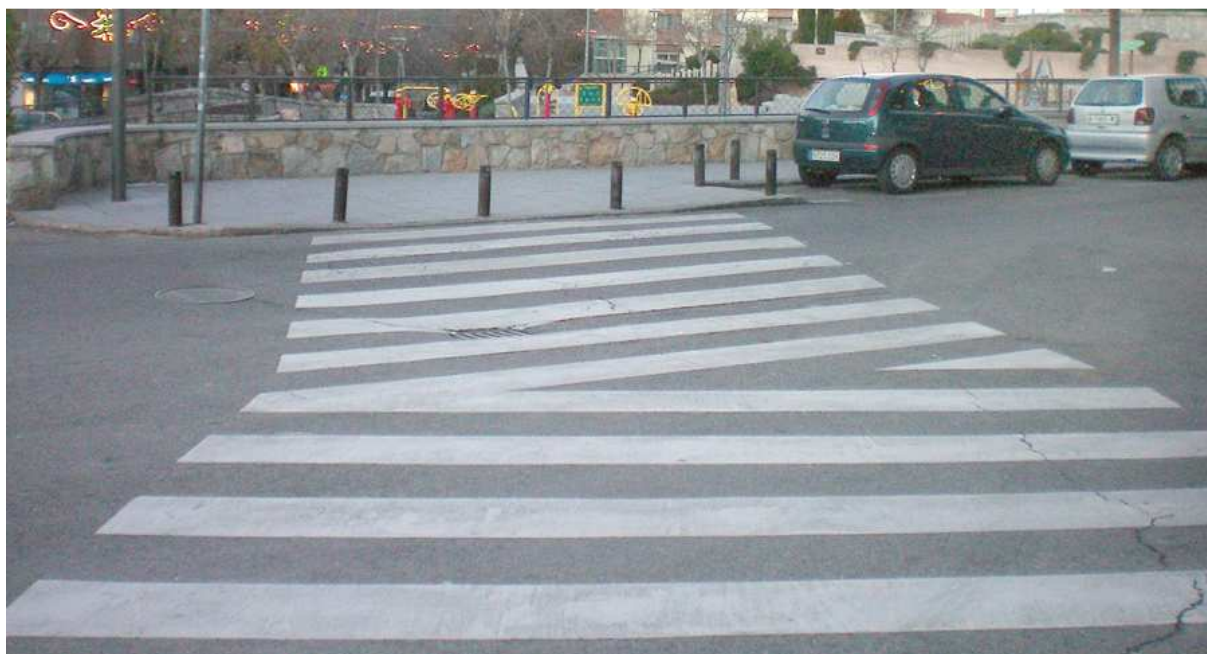
Imagen 22. Paso de peatones Aunque no es una situación habitual ni adecuada, cuando la dirección del paso de patones cambie en mitad de su trayecto, se deberá acotar la zona de cebreado mediante elementos de relieve en la calzada.
