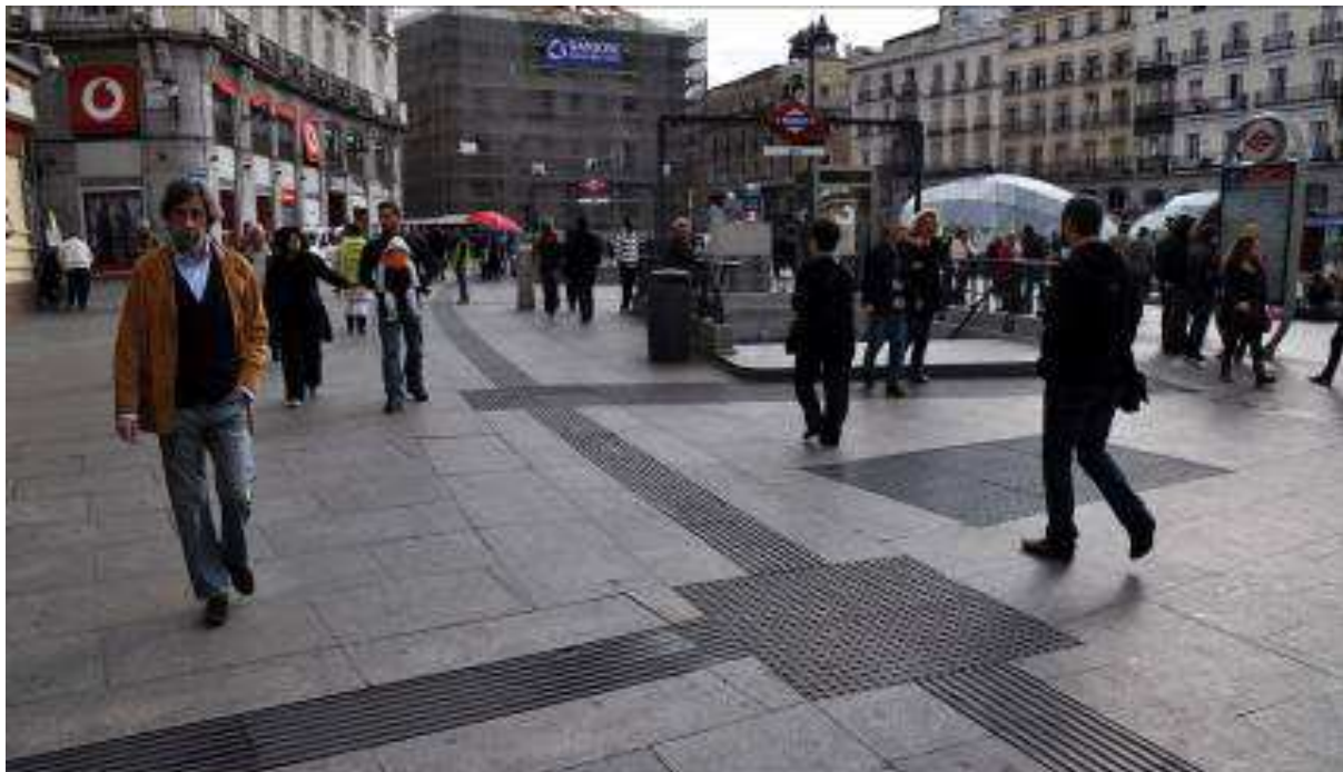
Imagen 04. Detalles de encaminamiento en la plaza Puerta del Sol donde pueden apreciarse las líneas y "rosetas".
