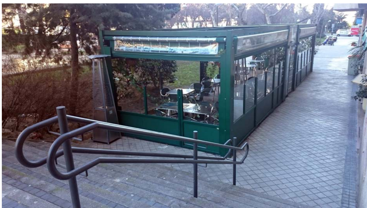
Imagen 30. Terraza de veladores en la calle de Raimundo Fernández Villaverde. Tipología cerrada.
