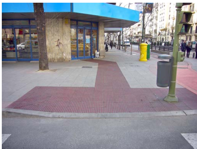
Imagen 07. Formación de vado de peatones con desnivel máximo de 3cm entre acera y calzada
