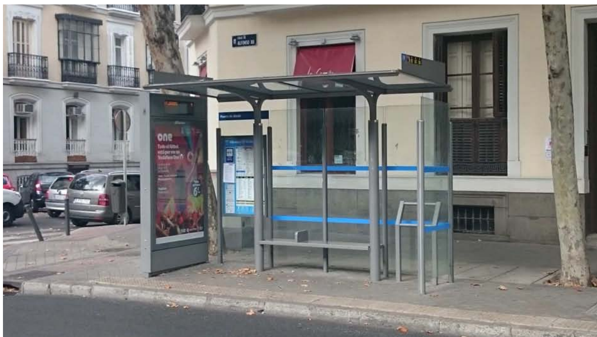
Imagen 11. Marquesina con banco, apoyo isquiático, señalización de los paneles de vidrio, etc. en la calle de Alfonso XII
