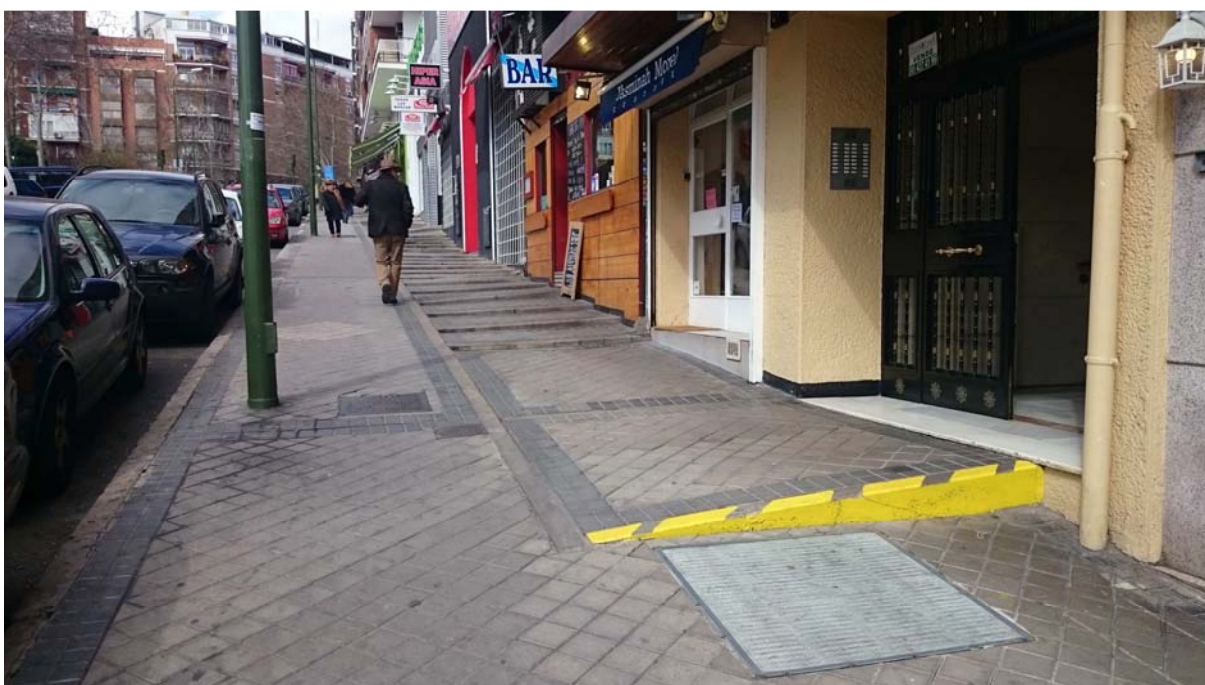
Imagen 13. Acera con elevada pendiente longitudinal en la calle de Santa Hortensia. En estas situaciones existe una evidente dificultad a la hora de compatibilizar los requerimientos del itinerario peatonal accesible, la topografía del entorno y el acceso a las fincas.
