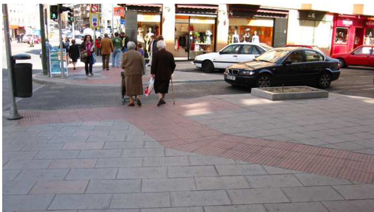
Imagen 18. Bandas de dirección y detección no alineadas. En la imagen se muestra una banda de dirección de un paso de peatones que quiebra su dirección hasta alinearla con la del cruce, dirigiendo de este modo a usuarios con discapacidad visual en el rumbo correcto.
