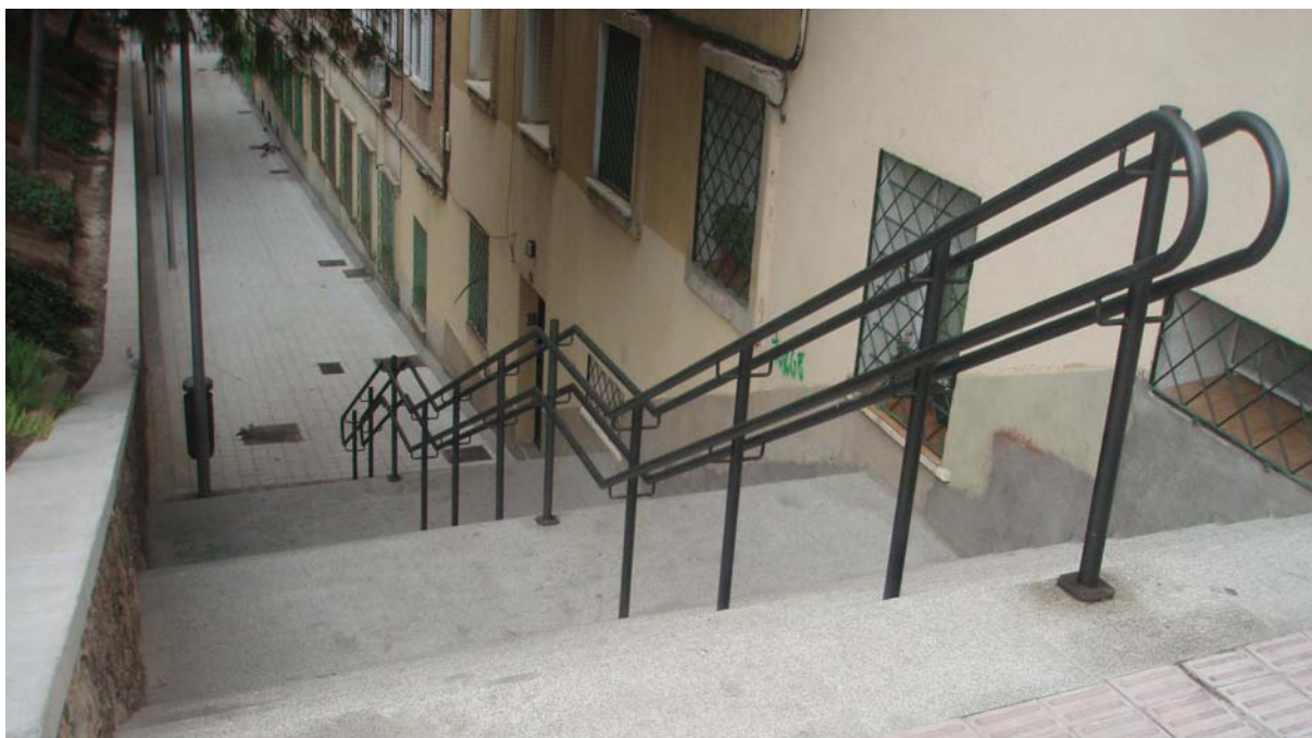
Imagen 09. Disposición de pasamanos en la zona central al no ser posible adosarlo al lateral derecho por la presencia de ventanas en la fachada en la calle Vertiente
