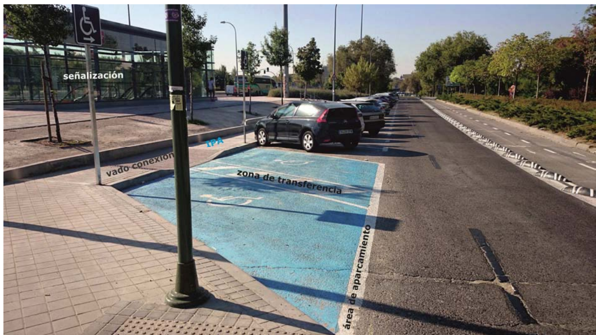
Imagen 05. Detalle composición de un estacionamiento reservado en la calle de Santiago Amón. La conexión entre el itinerario peatonal y la franja de transferencia lateral se configura mediante un vado en la acera.
