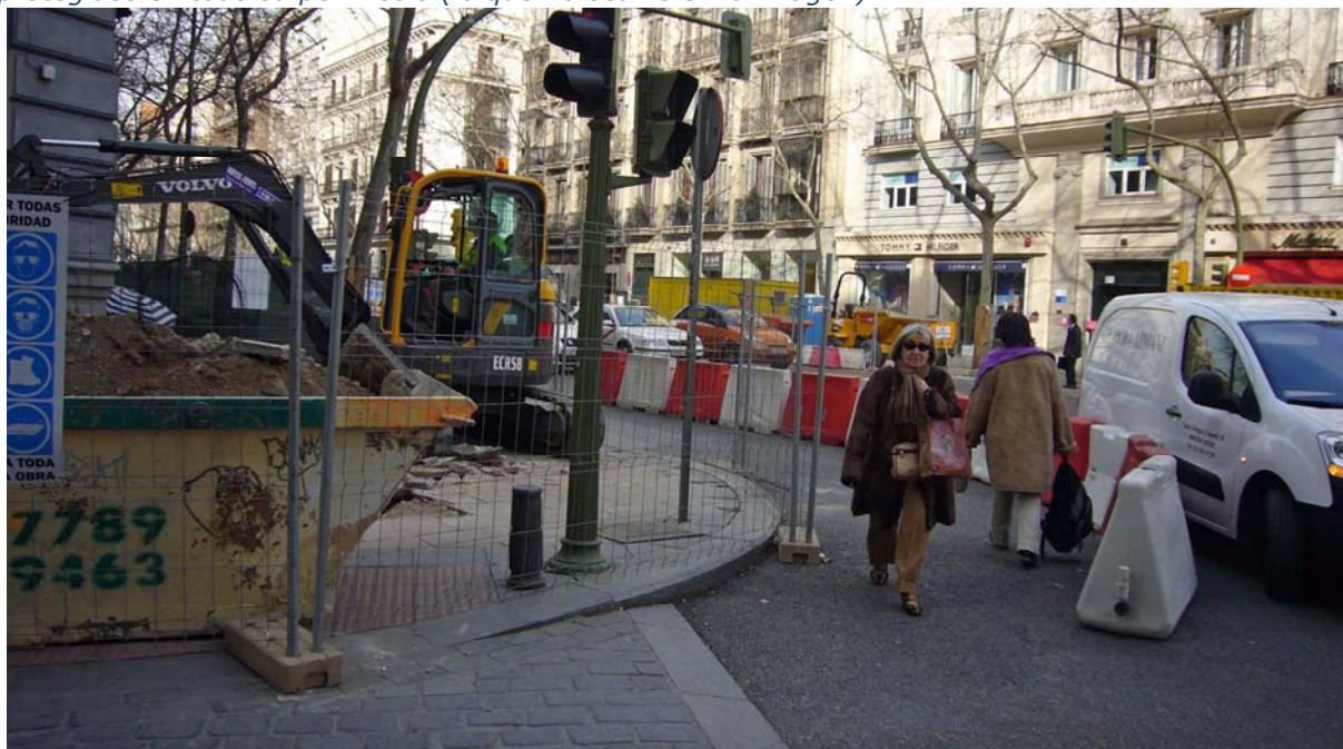
Imagen 07. La prioridad del recorrido alternativo debe quedar claramente marcada y acotada respecto a la calzada.
