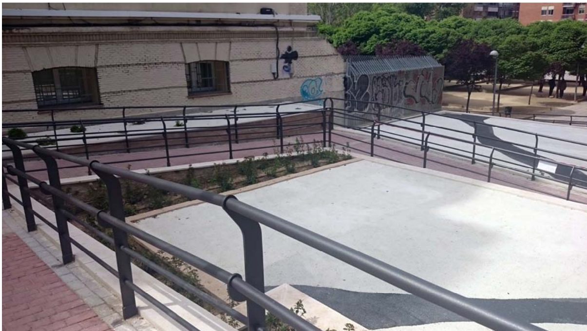
Imagen 09. Rampa en la calle de Canarias Ejemplo de pasamanos accesible a doble altura con continuidad en todo su recorrido
