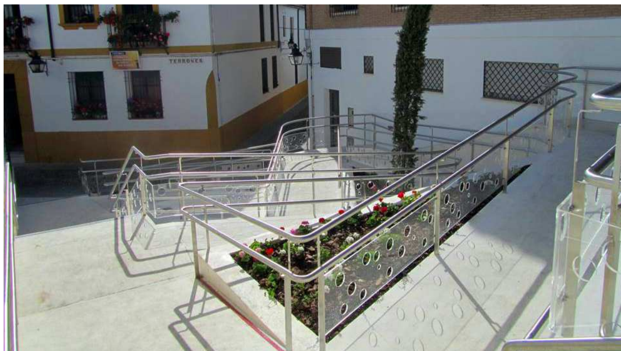
Imagen 13. Combinación de trazado de rampa y escalera con empleo de petos de protección transparentes y pasamanos accesible, en la calle Terrones en Córdoba
