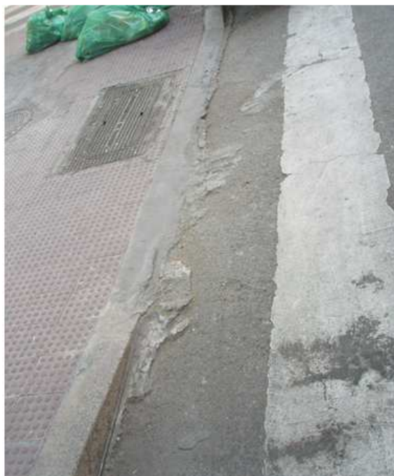
Imagen 21. Construcción del acuerdo acera-calzada En su ejecución debe replantearse correctamente el desnivel existente a fin de evitar generar escalones, y más aún intentar resolverlo mediante elementos añadidos que invaden la calzada como en la imagen de la derecha.
