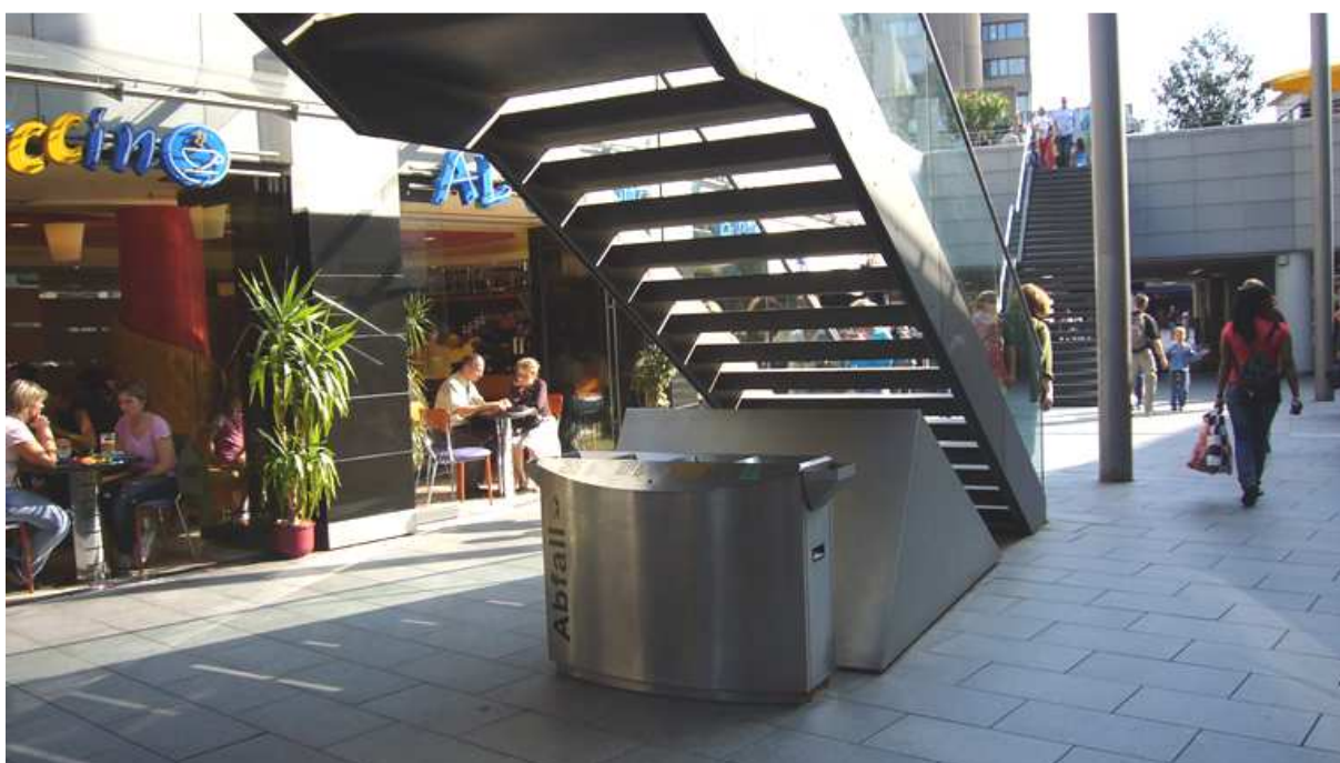
Imagen 12. Protección bajo rampa En ocasiones el diseño de la escalera presenta un espacio bajo el desarrollo de los peldaños cuya altura es inferior a 2,20 m. En estos casos dicho espacio debe protegerse con un elemento de altura mínima 25 cm para que pueda ser identificada por parte de usuarios de bastón, evitando accidentes
