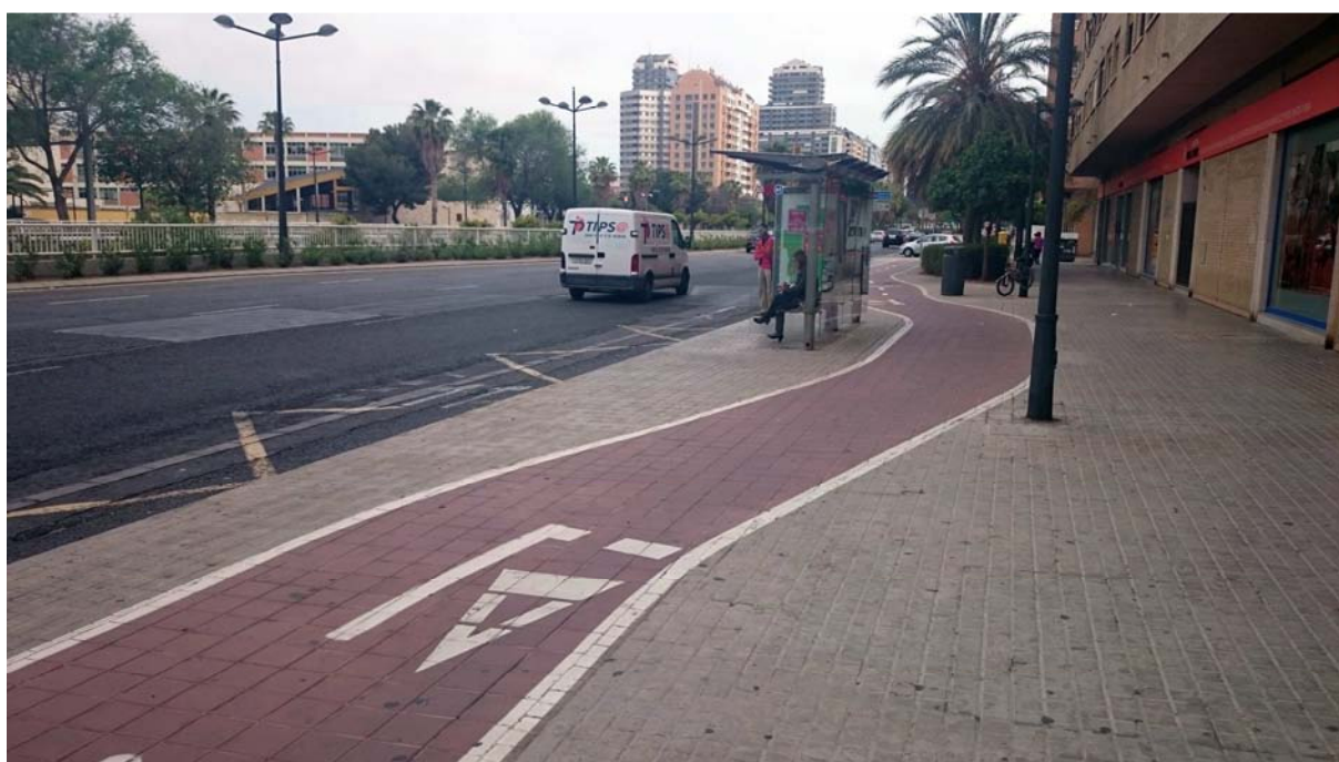
Imagen 15. Acera-bici en Valencia situada por detrás de la marquesina de la parada de autobús.
