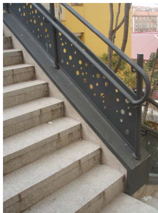
Imagen 10. Detalle de formación de peto de protección y pasamanos accesible en escalera
