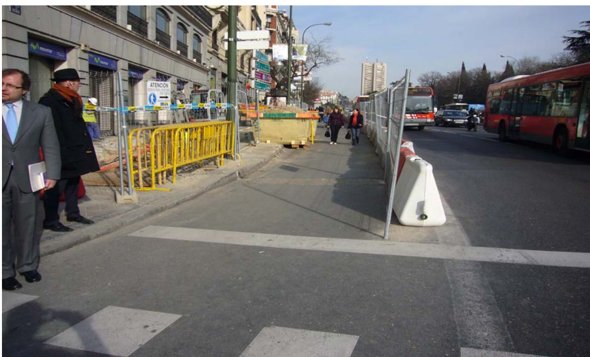
Imagen 01. Protección de itinerario alternativo por obras en vía pública. Se observa que no se ha resuelto adecuadamente el escalón producido en la conexión entre el itinerario peatonal existente y el provisional
