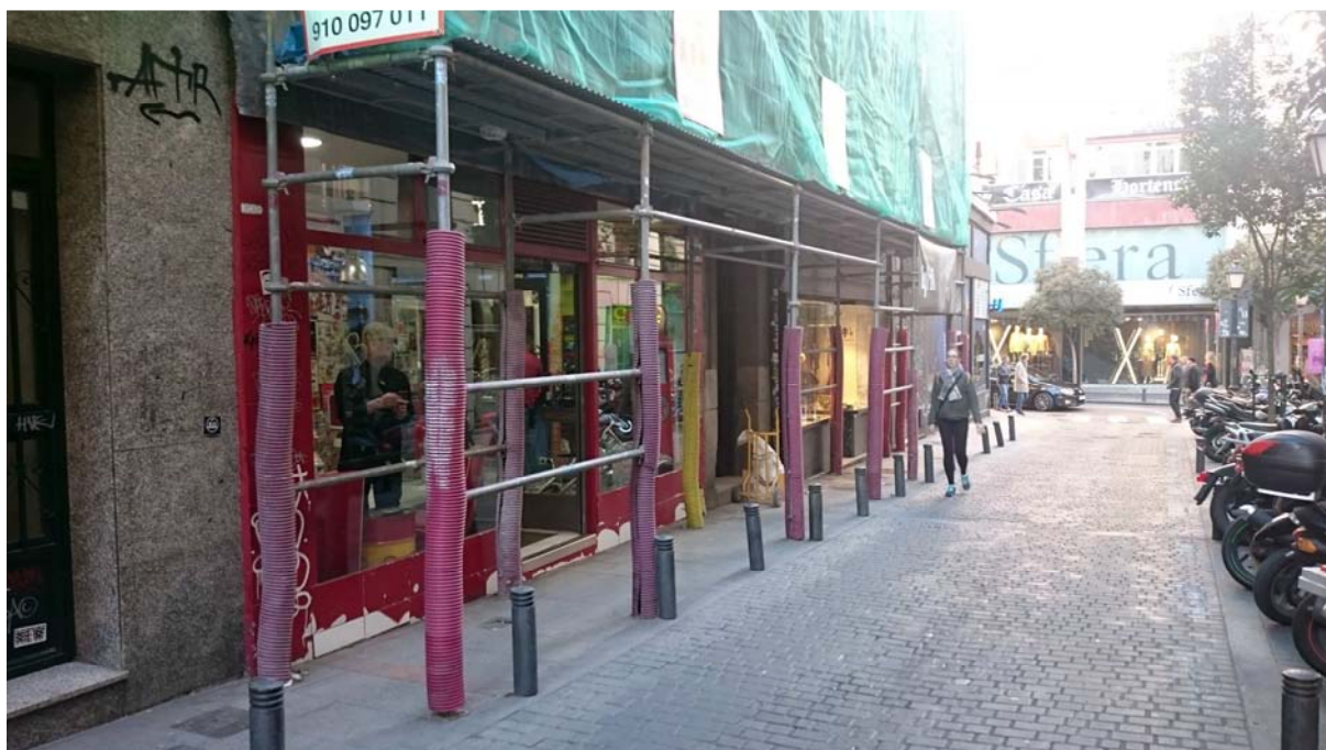
Imagen 04. Protección de andamios en vía pública
