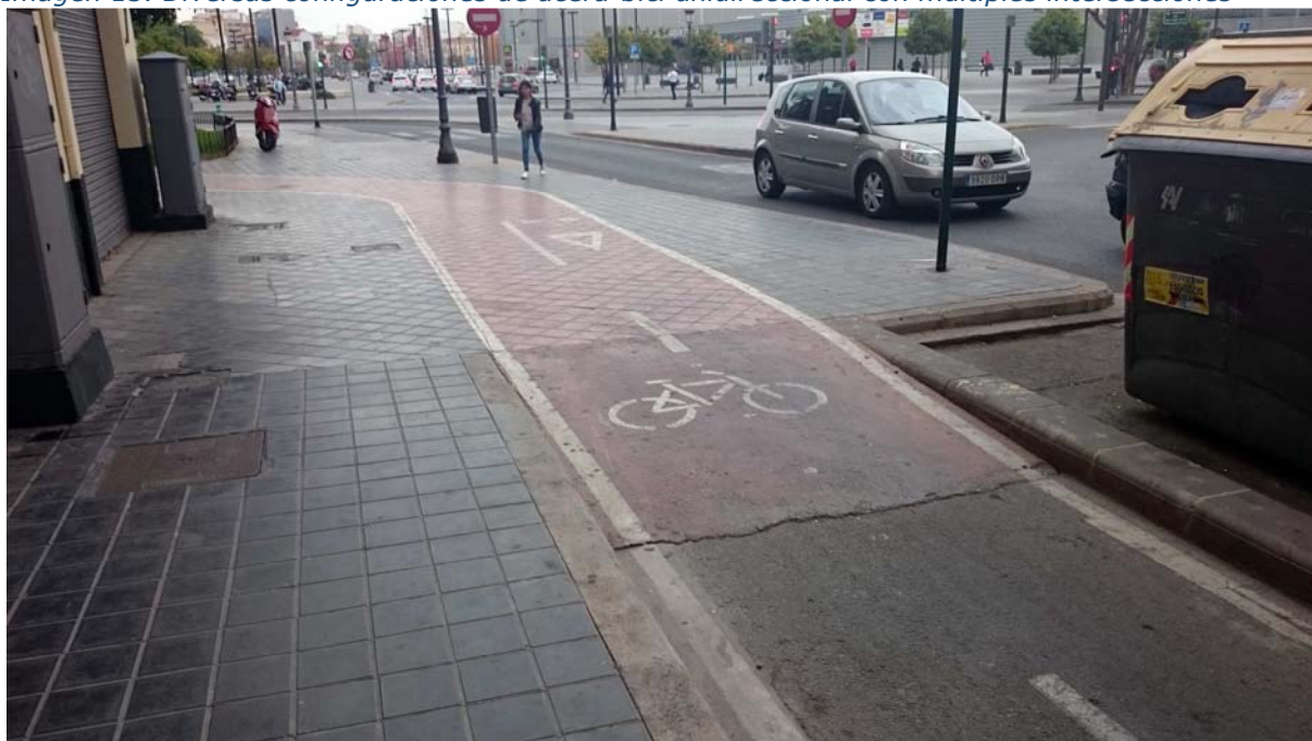
Imagen 14. Transición acera-bici a carril-bici en Valencia
