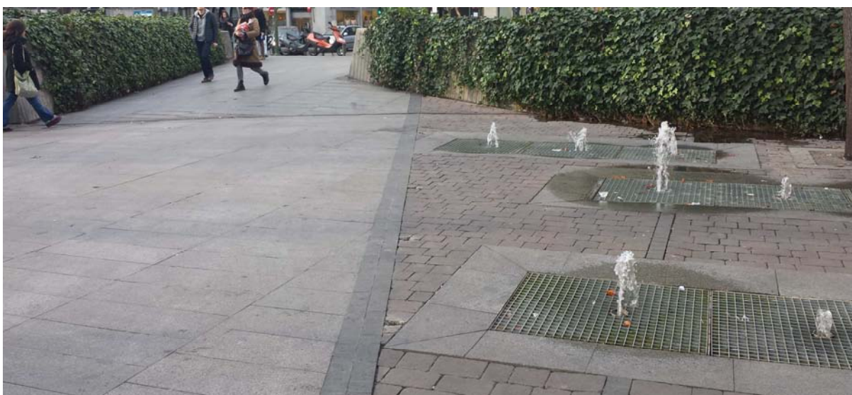
Imagen 06. Lámina de agua y fuente protegida con rejilla y pavimento perimetral diferenciado, situada en la Plaza de Tirso de Molina.
