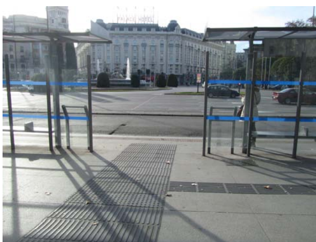
Imagen 19. Ubicación de pavimentos podotáctiles para señalar la parada de autobús y encaminamiento al paso de peatones.
