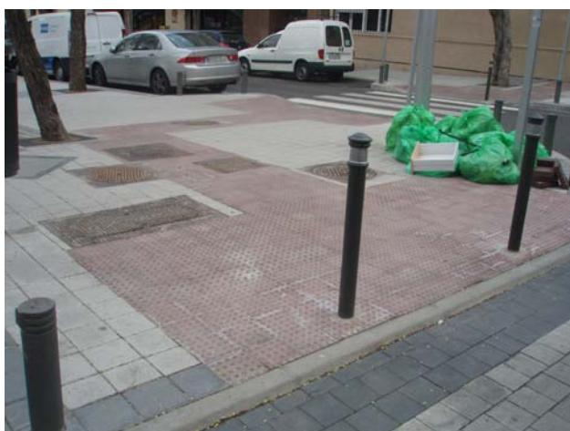
Imagen 10. Uso de pavimentos en el cruce de dos pasos de peatones
