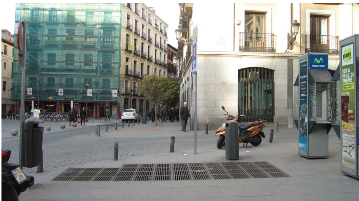
Imagen 12. Detalle de rejilla de gran dimensión en itinerario peatonal accesible
