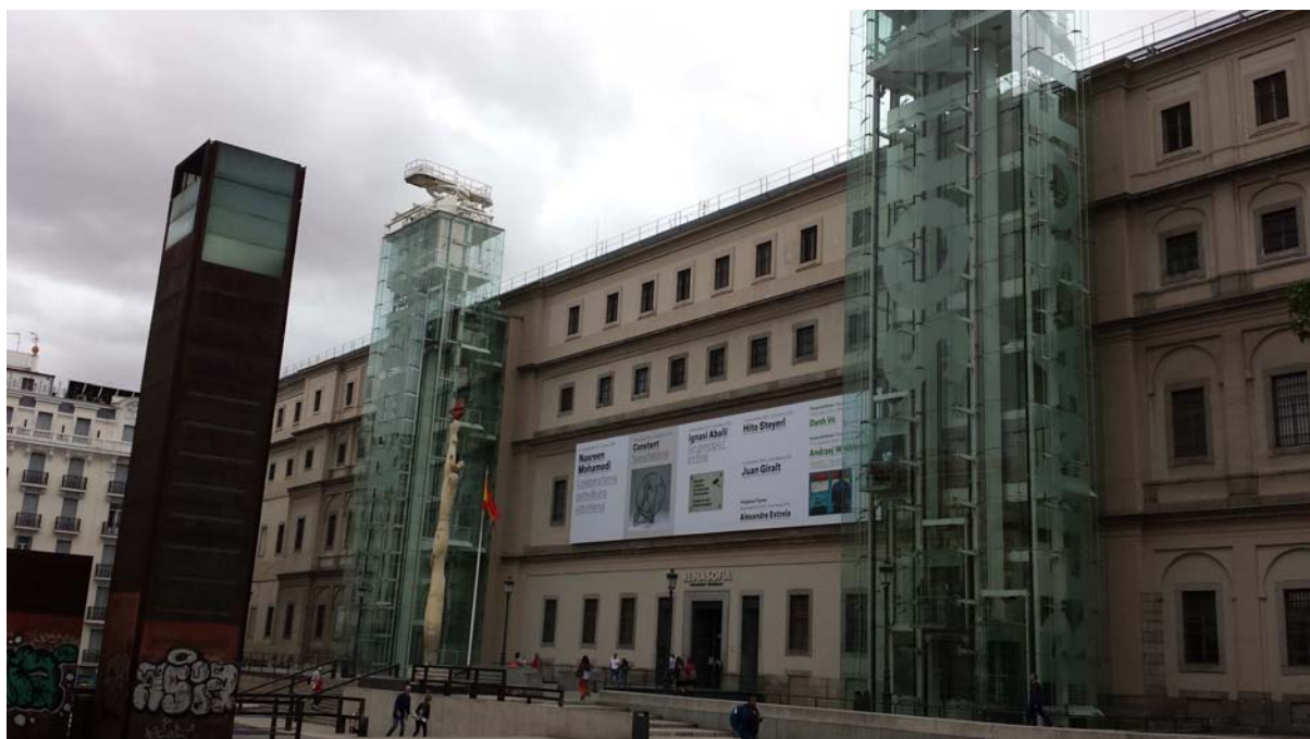
Imagen 07. Ascensor de acceso al Centro de Arte Reina Sofía El uso de un cerramiento acristalado favorece la comunicación visual con el exterior, facilitando el auxilio ante situaciones de emergencia
