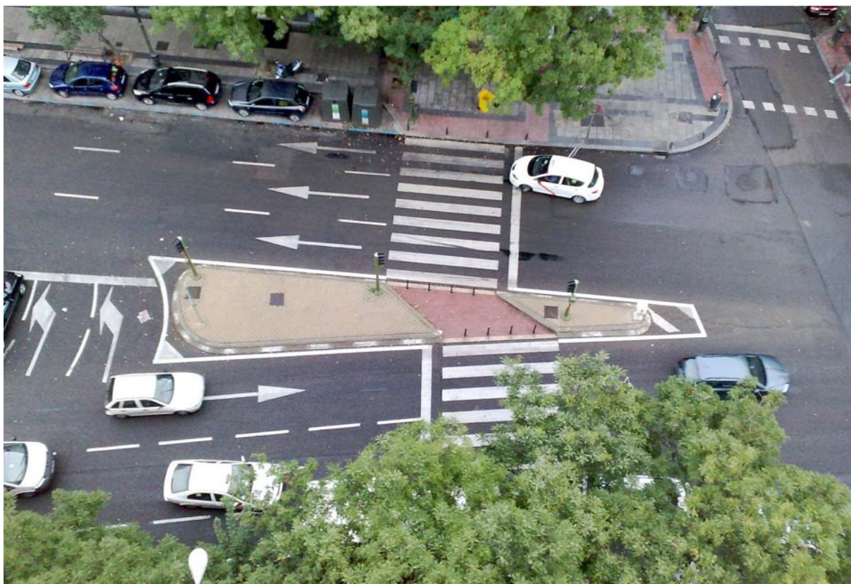
Imagen 01. Paso de peatones con isleta intermedia en la calle de San Bernardo
