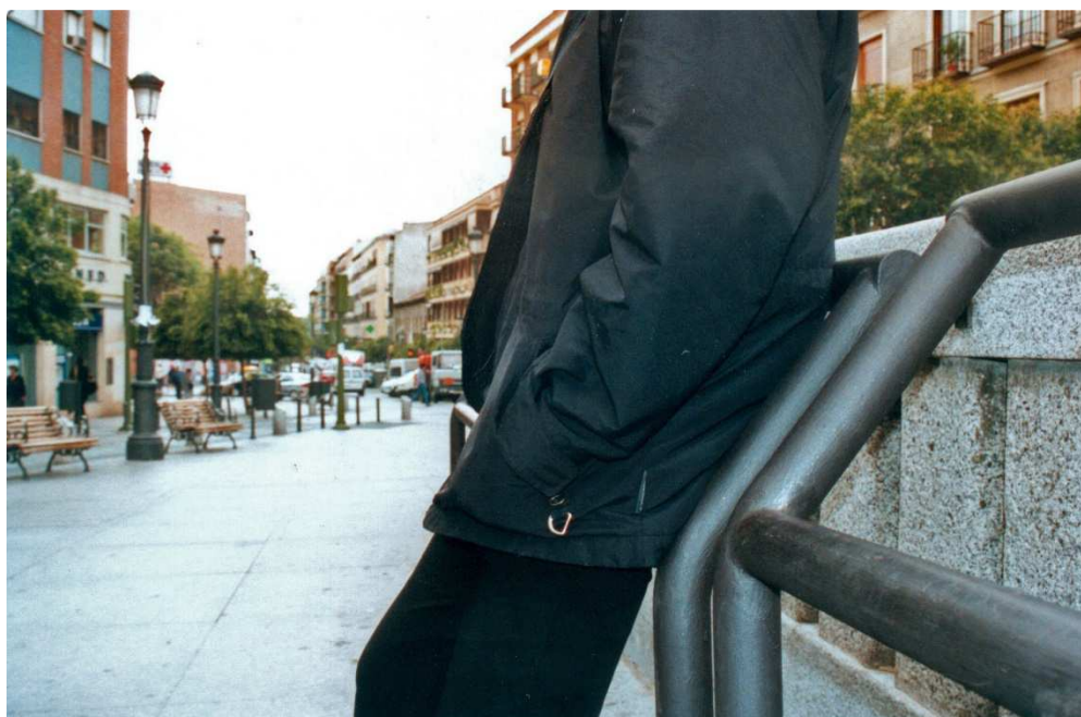
Imagen 28. Detalle de apoyo isquiático en vía pública
