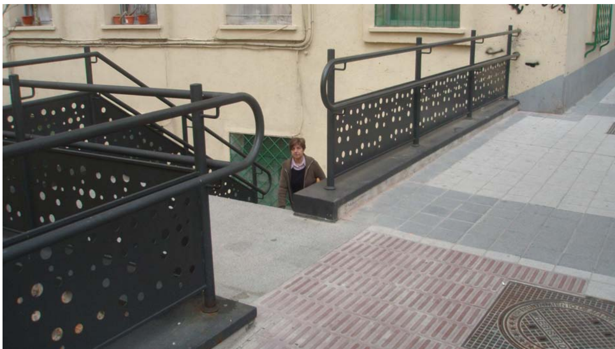
Imagen 11. En la imagen puede observarse la disposición de un rellano previo a la escalera para evitar su inicio desde la alineación de la acera. Sin embargo el pavimento tacto visual se dispone en la acera para que se detectada desde el itinerario peatonal en la calle de Marcelino Álvarez
