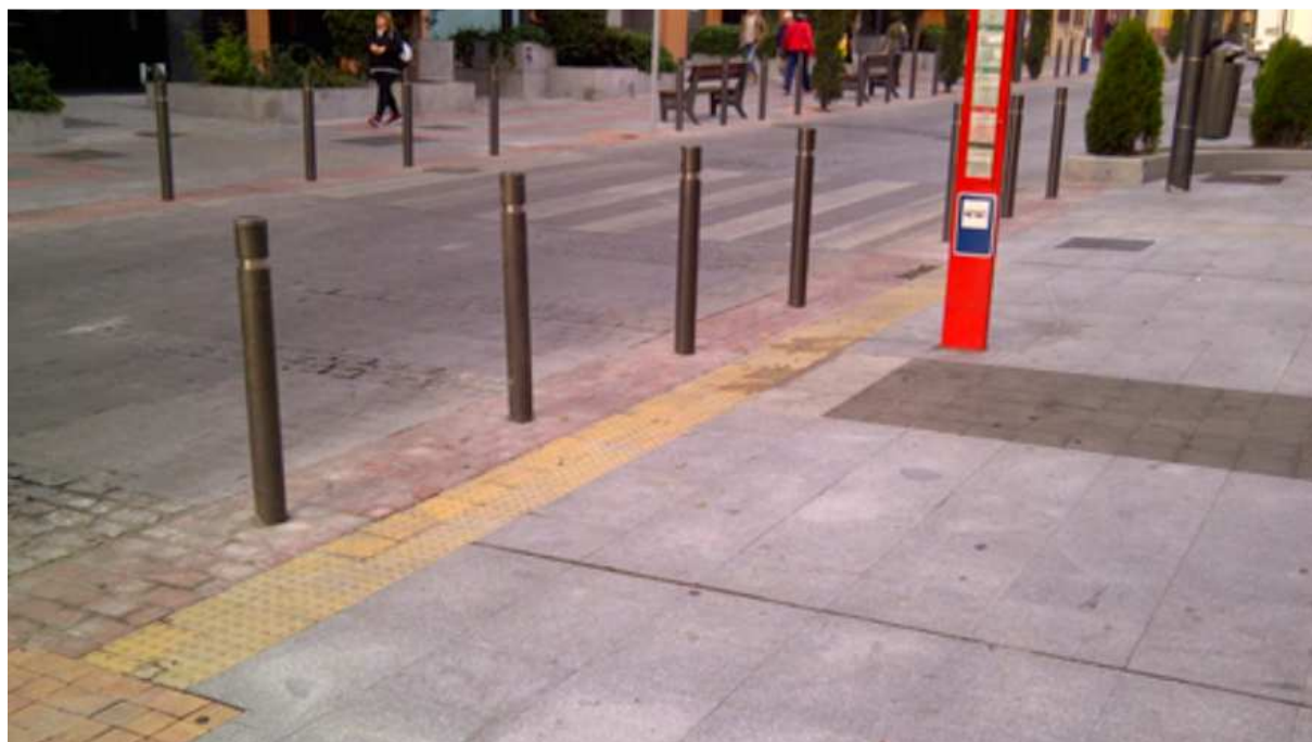
Imagen 05. Disposición de pavimentos tacto visuales en un poste de parada de autobús urbano
