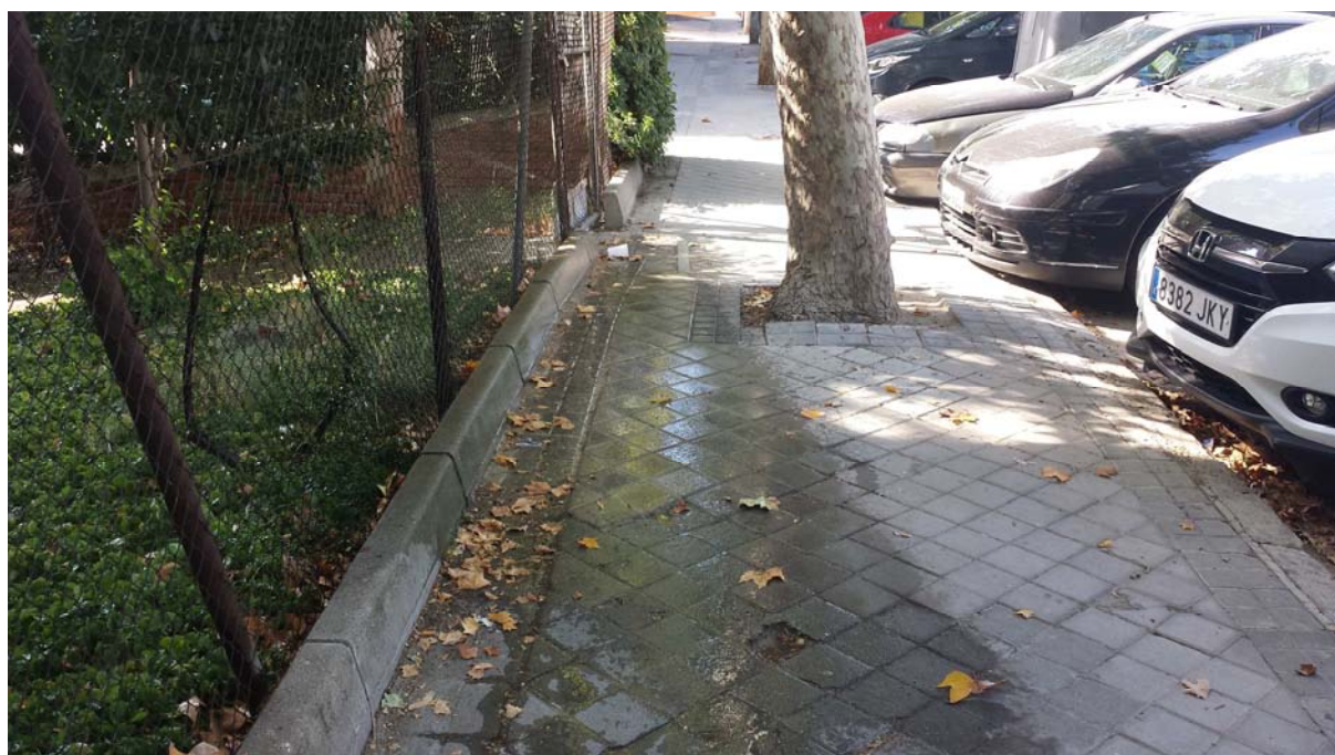
Imagen 17. El riego de las zonas verdes debe realizarse evitando el encharcamiento de las aceras colindantes
