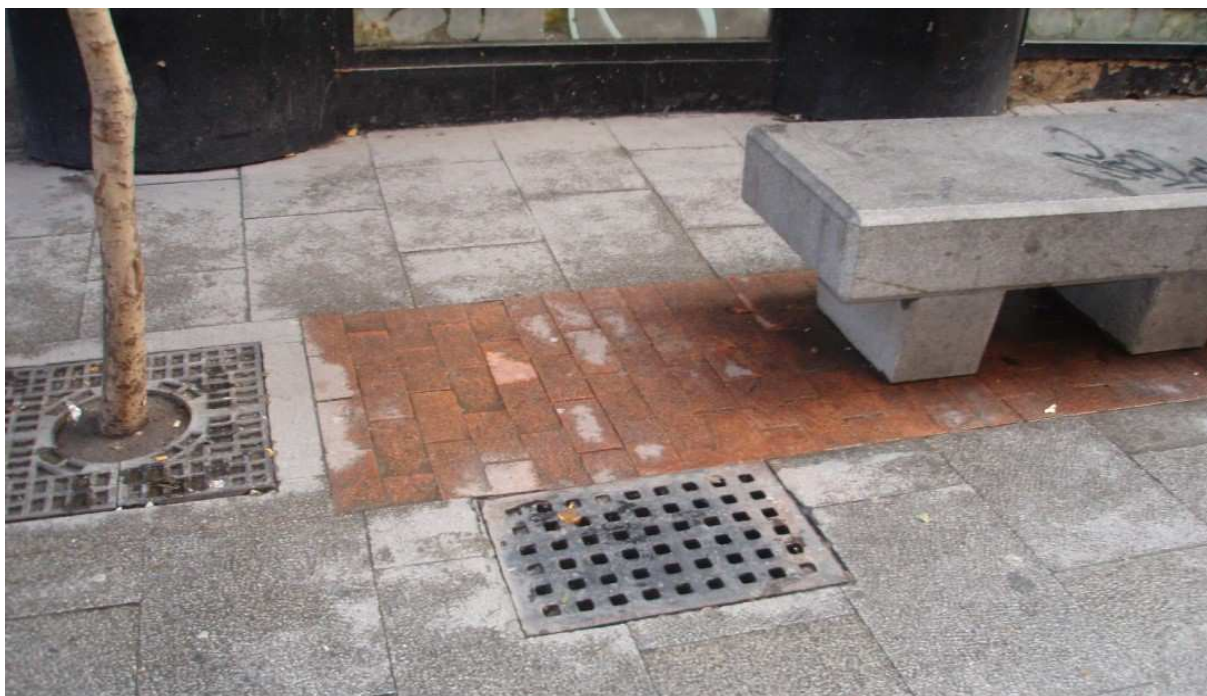
Imagen 14. Detalle de rejilla ubicada contigua a la banda de mobiliario dentro del itinerario peatonal accesible
