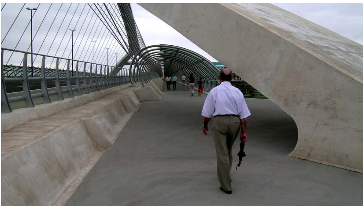
Imagen 04. Puente del Tercer Milenio en Zaragoza. Las reducciones de gálibo en el itinerario peatonal deben evitarse o, en su caso, señalizarse adecuadamente
