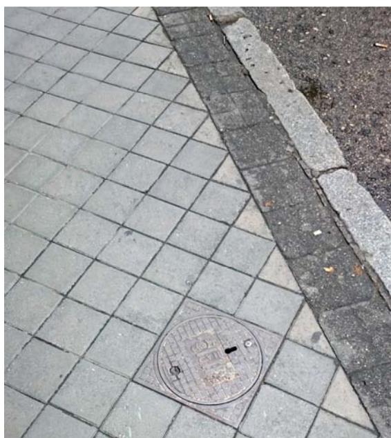
Imagen 11. Correcta colocación de una tapa de registro. La tapa está expresamente diseñada para facilitar su enrasamiento con el pavimento y para no precisar cortes en las piezas de pavimentación más habituales en el municipio de Madrid.
