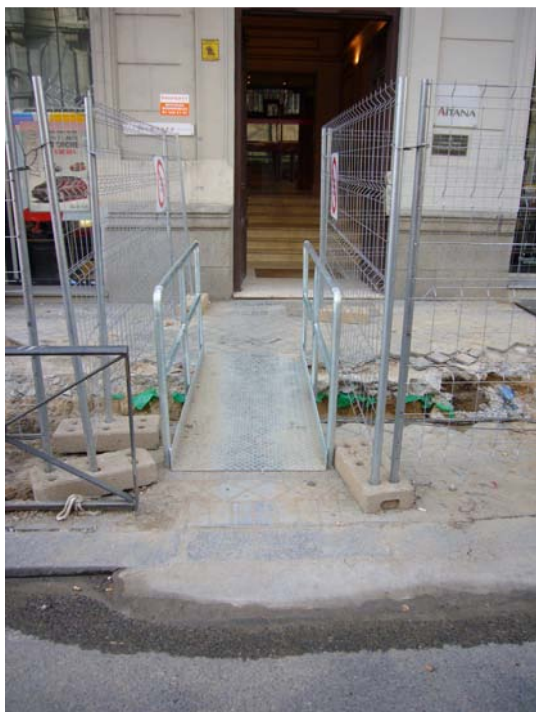
Imagen 08. Cuando sea necesario construir itinerarios alternativos entre los niveles de calzada y acera los planos inclinados que se generen tendrán la condición de rampas, y como tales ajustarán su pendiente a un máximo de 10% y se dotarán de pasamanos laterales y zócalo inferior.
