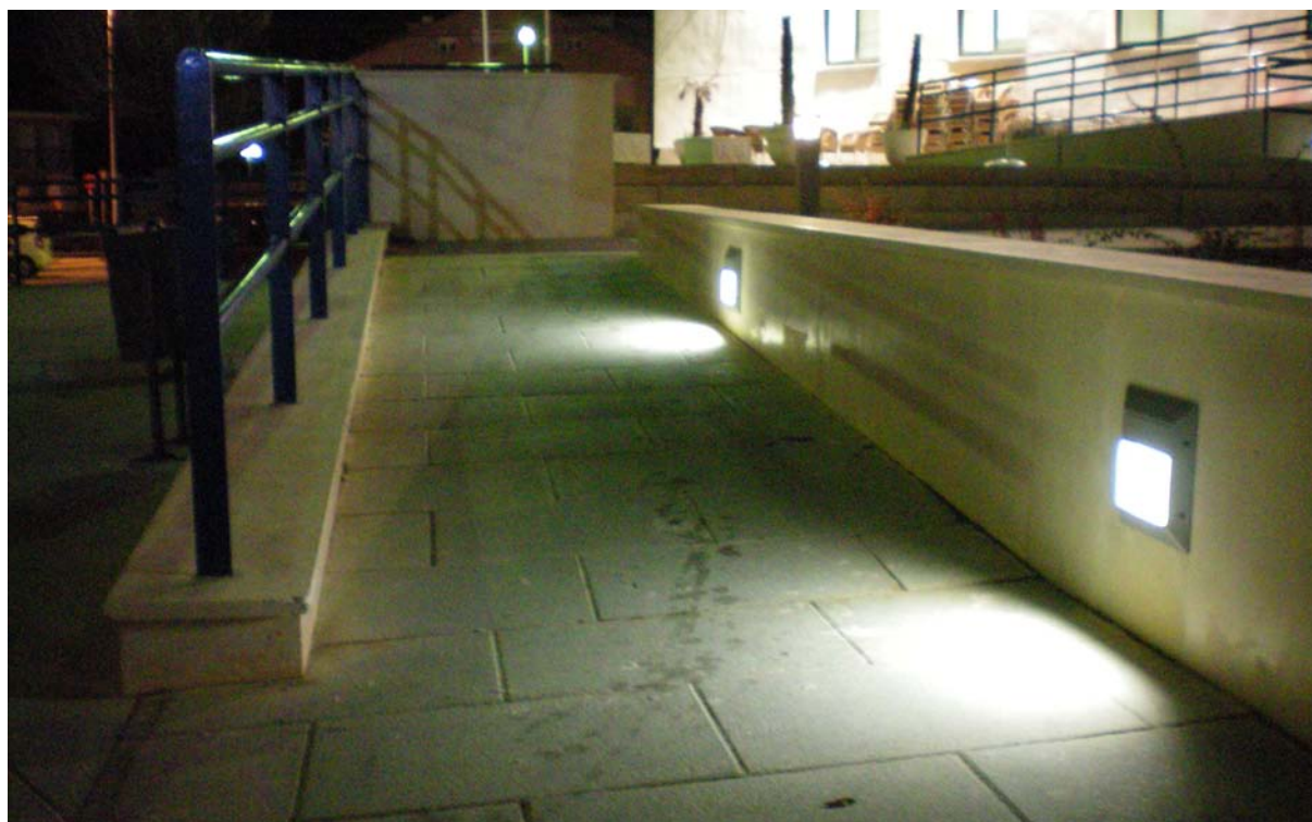
Imagen 13. Refuerzo de la iluminación en rampas mediante focos orientados al plano del suelo para evitar deslumbramientos
