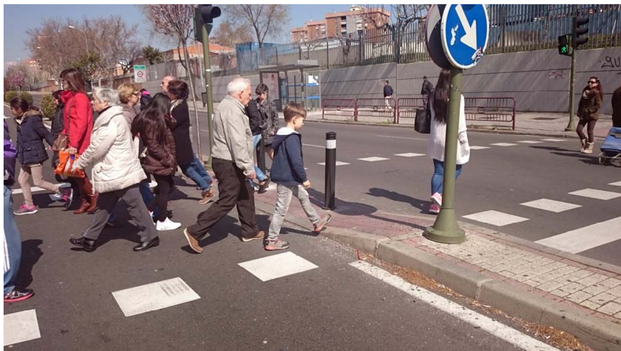
Imagen 27. Isleta de dimensiones claramente insuficientes, en un cruce de alta afluencia peatonal, en la avenida de los Poblados.
