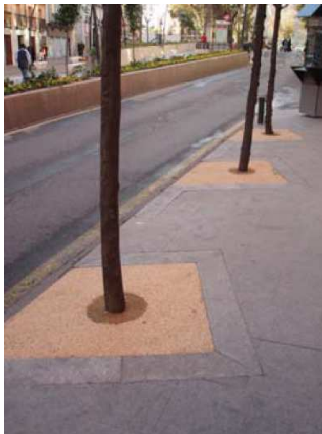
Imagen 25. Diseño de alcorque enrasado con el pavimento
