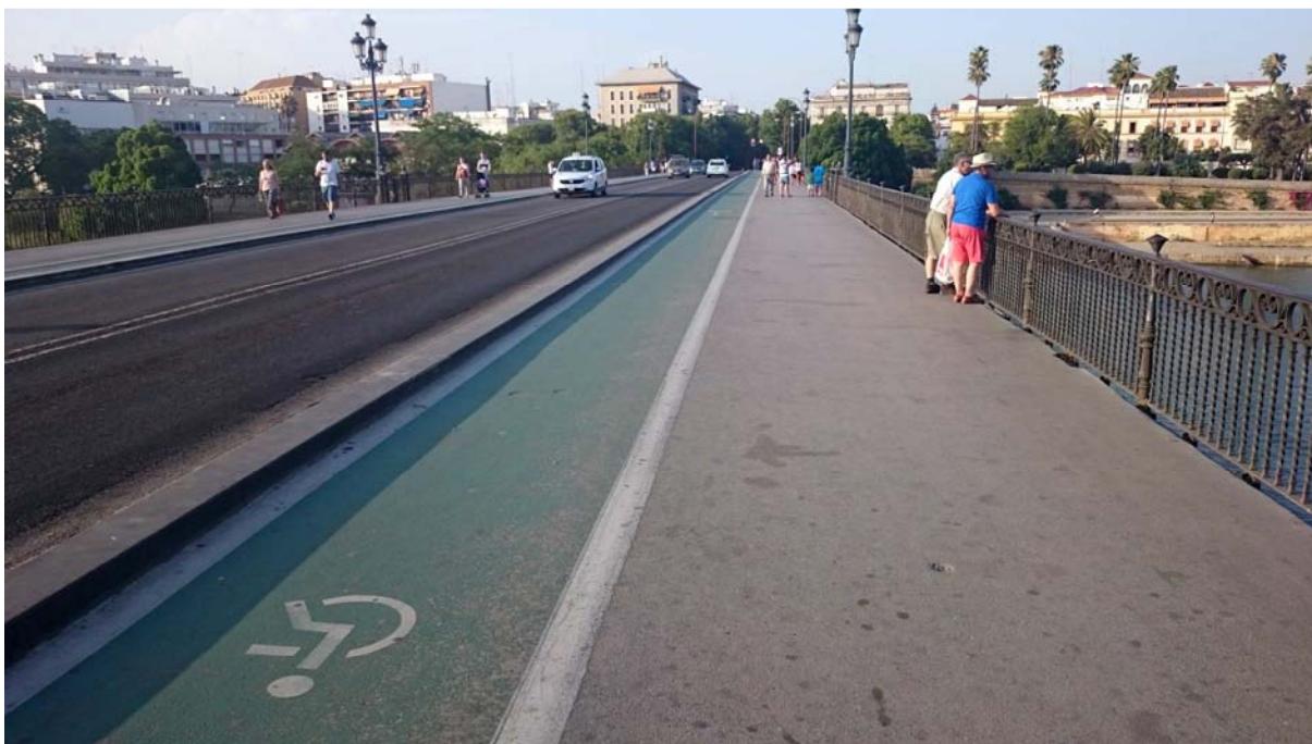
Imagen 05. Acera-bici en Sevilla con señalización que recomienda su utilización para usuarios de silla de ruedas
