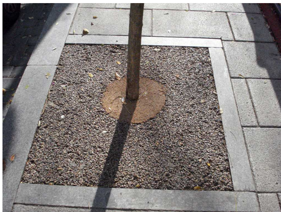
Imagen 15. Ejemplo de alcorque enrasado con el pavimento en Plaza de Callao
