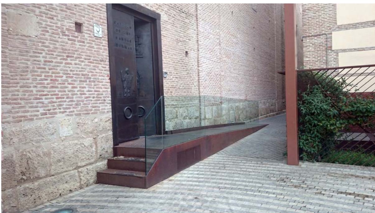
Imagen 03. Rampa removible de acceso a edificio protegido en Alcalá de Henares
