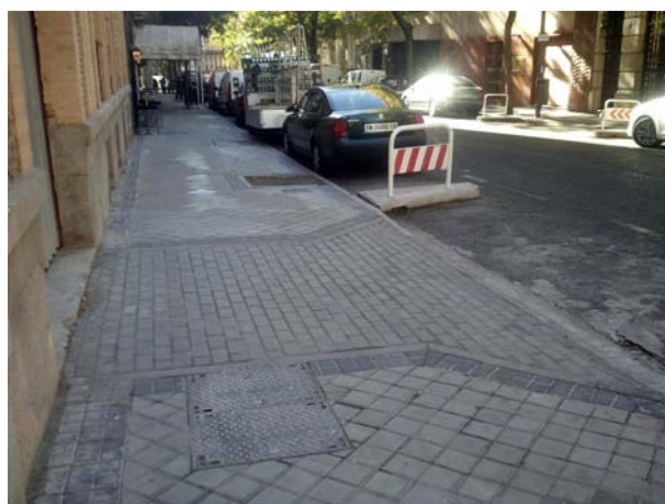
Imágenes 03 y 04. Vados de vehículos con pavimentos de aspecto peatonal.
