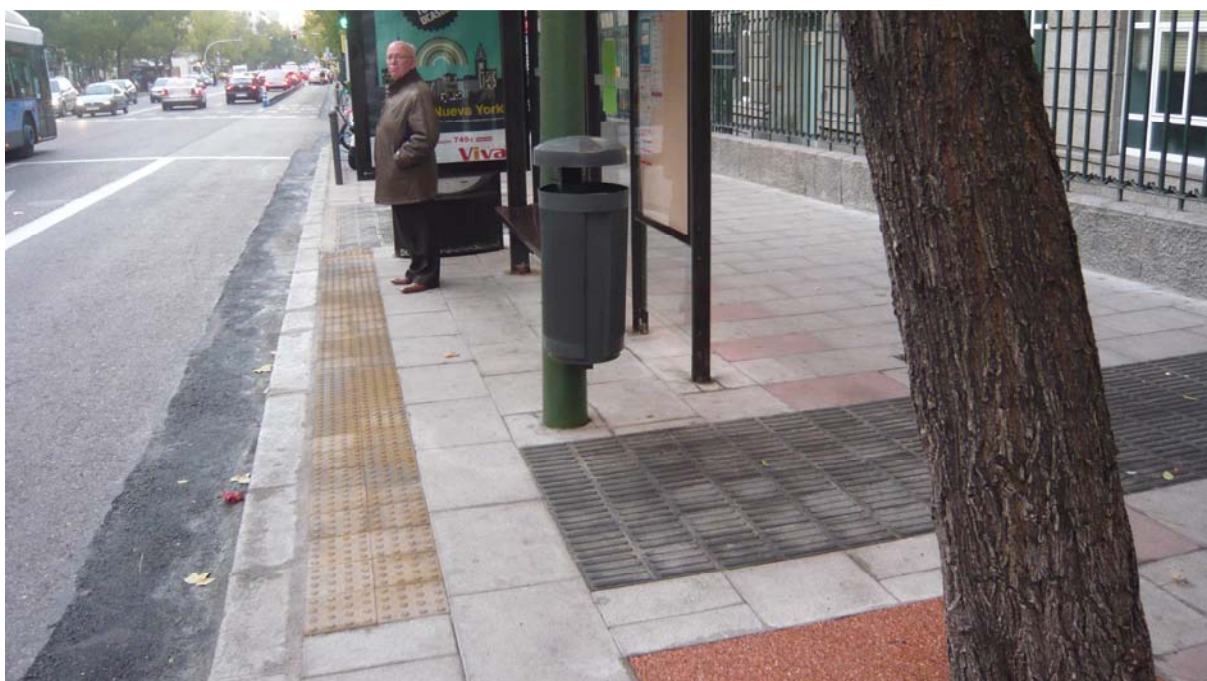
Imagen 02. Empleo de pavimentos tacto visuales en una marquesina de autobús urbano
