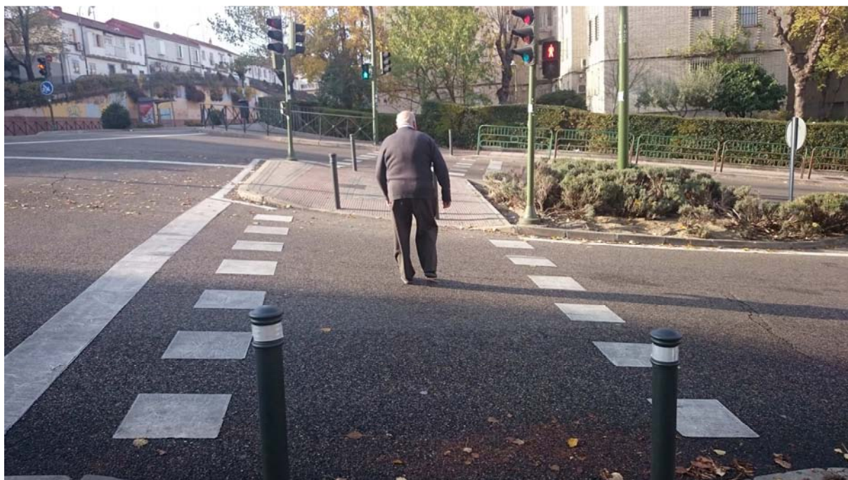
Imagen 28 Paso de peatones con excesiva pendiente transversal en la calle de Cebreros.
