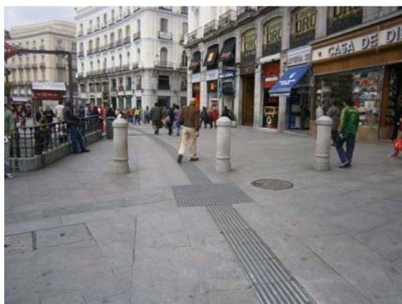
Imagen 08. Uso de encaminamientos mediante baldosas tacto-visuales de acanaladura a modo de guía en los recorridos de un espacio público abierto.
