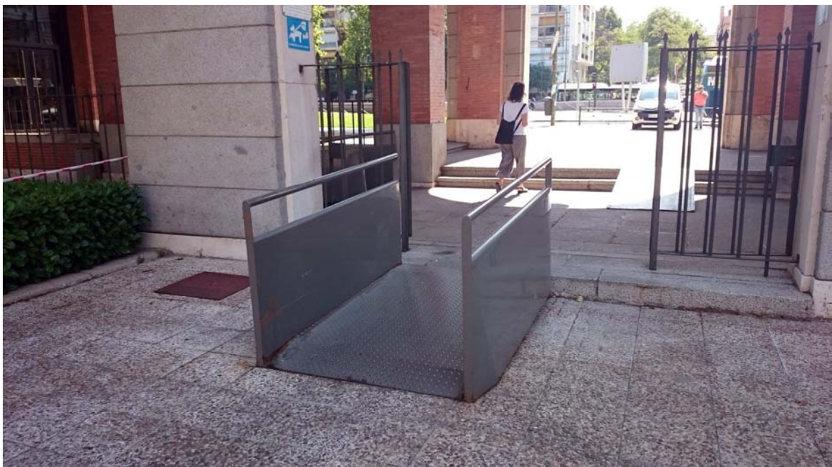
Imagen 01. Rampa removible en los Nuevos Ministerios
