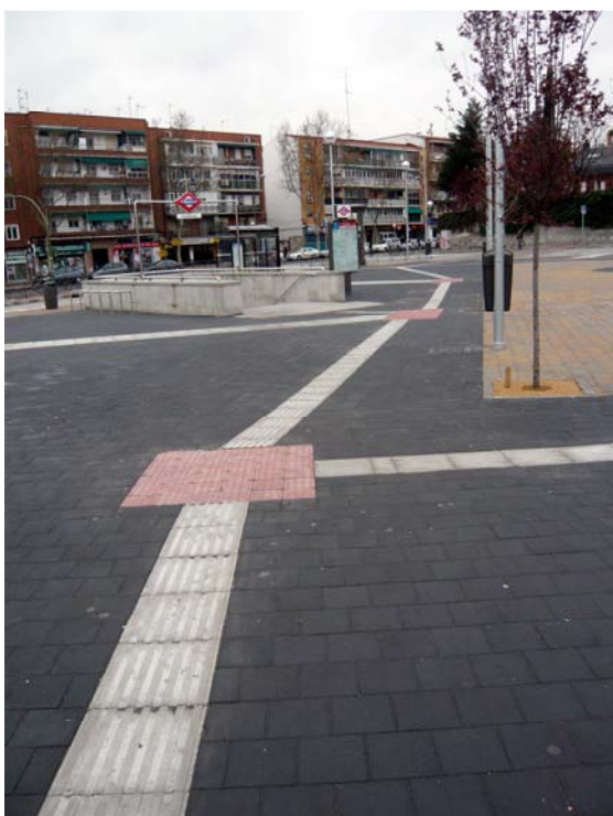
Imagen 22. Encaminamiento direccional con rosetas para indicar el cambio de dirección hacia para de transporte público, paso de peatones, etc.
