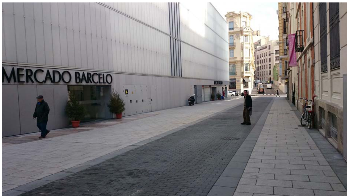
Imagen 14. Detalle del itinerario peatonal accesible en la calle de la Beneficencia. Se puede observar una calle de plataforma única donde se delimitan las áreas peatonales respecto al área compartida con los vehículos mediante pavimentos diferenciados sin el empleo de bolardos
