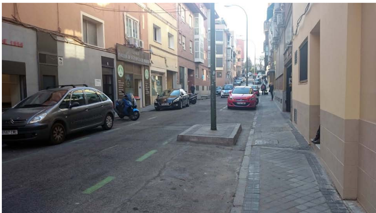
Imagen 15. Calle de Saturnino Calleja. En este caso, ante la reducida anchura de la acera, se ha optado por el traslado de soportes de alumbrado público a la banda de aparcamiento.
