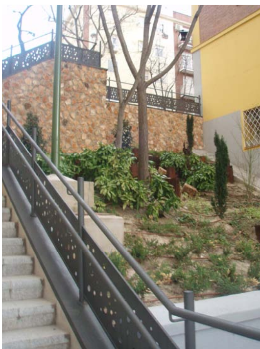
Imagen 10. Detalle de formación de peto de protección y pasamanos accesible en escalera
