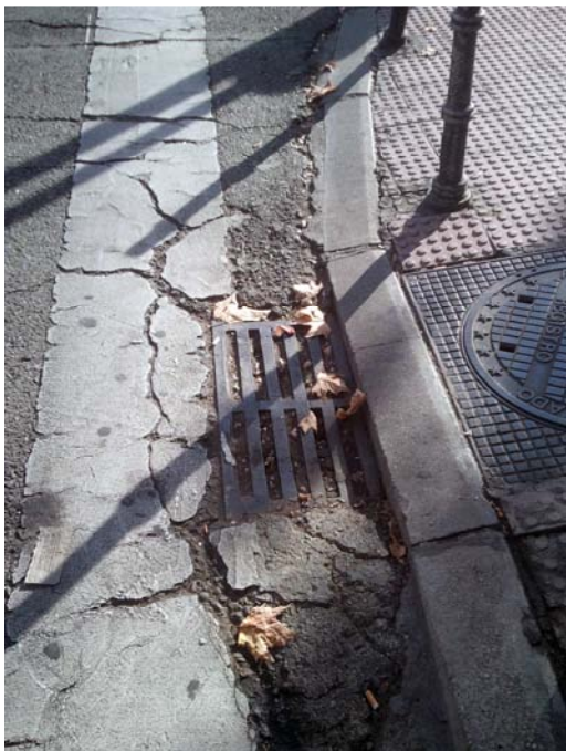
Imagen 09. Estado de conservación de un elemento de drenaje superficial que provoca, en días de lluvia, un encharcamiento en el vado de peatones
