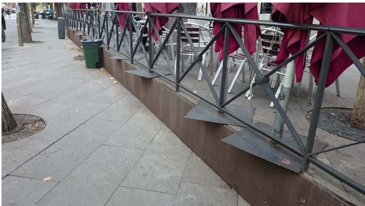
Imagen 13. Invasión de elementos auxiliares de una terraza al itinerario peatonal accesible
