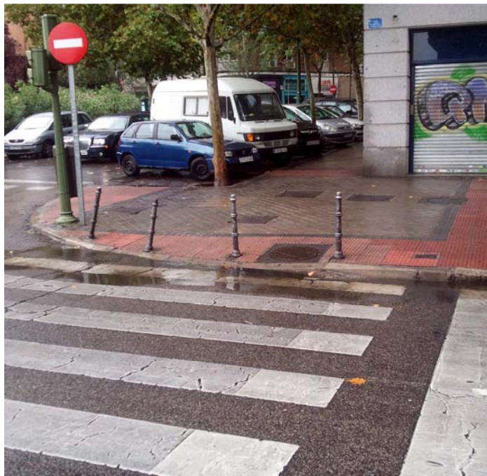
Imagen 09. Estado de conservación de un elemento de drenaje superficial que provoca, en días de lluvia, un encharcamiento en el vado de peatones
