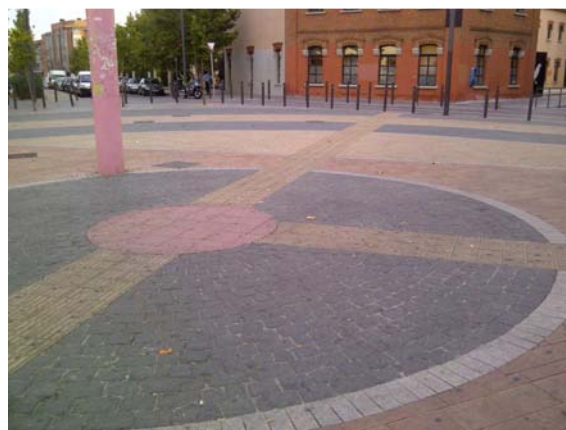
Imagen 08. Uso de encaminamientos mediante baldosas tacto-visuales de acanaladura a modo de guía en los recorridos de un espacio público abierto.
