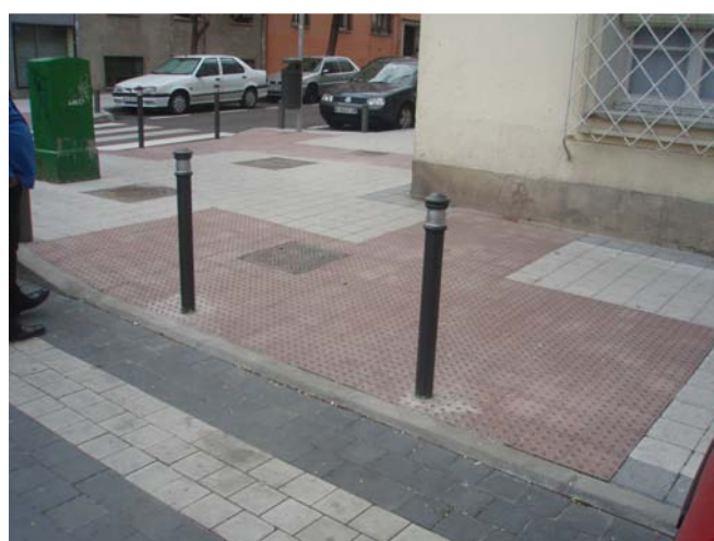
Imagen 03. Formación de vado de peatones con desnivel máximo de 3 cm entre acera y calzada
