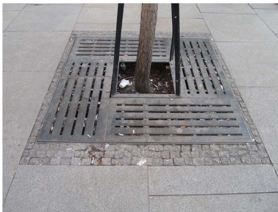
Imagen 17. Detalle de alcorque enrasado con pavimento a través de una rejilla metálica.
