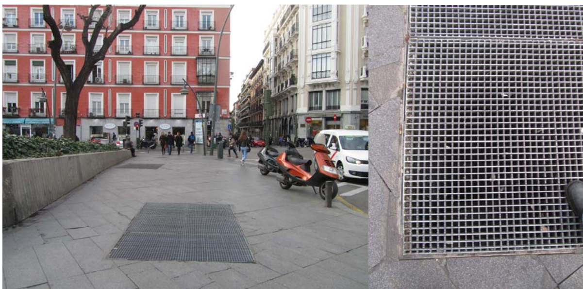
Imagen 08. Detalle de rejilla de gran dimensión en la plaza de Tirso de Molina en el itinerario peatonal, con diámetros de orificio adecuados para el paso seguro de las personas
