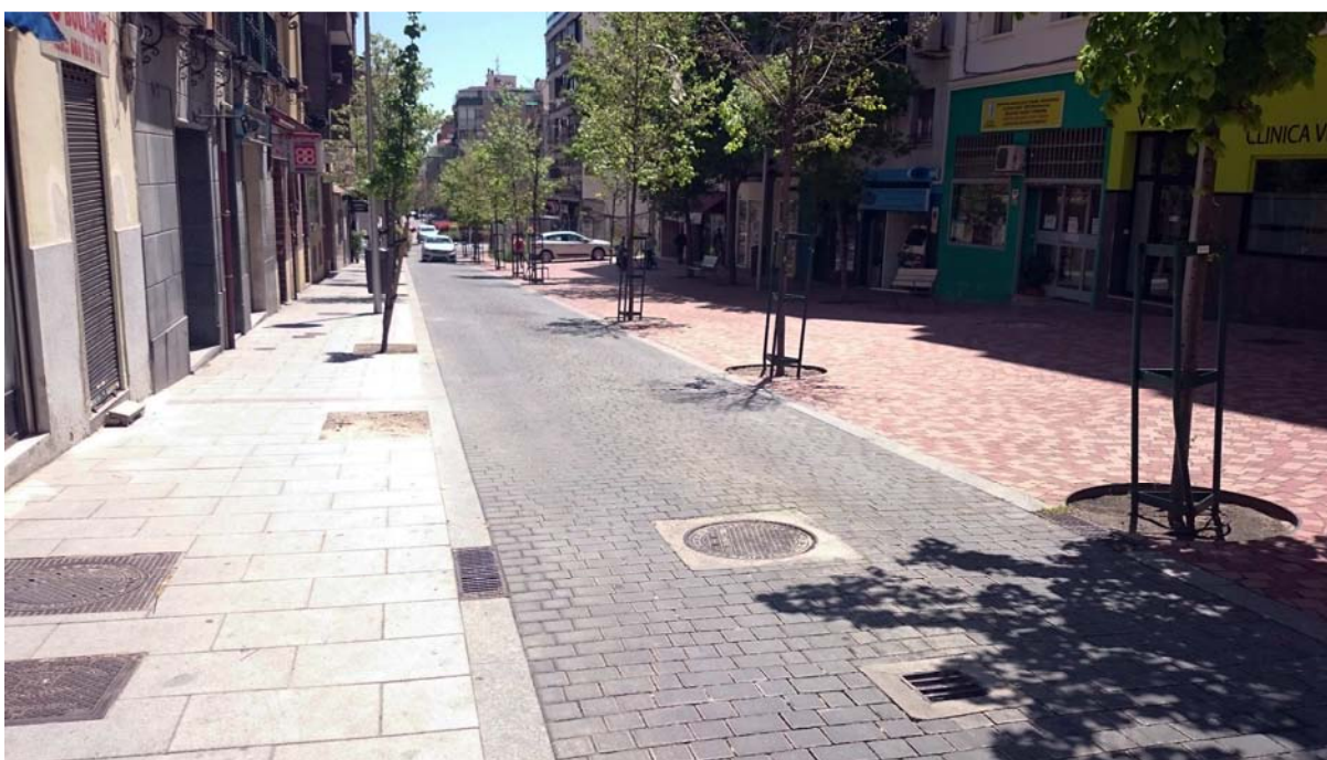
Imagen 11. Pavimentos en itinerario peatonal accesible en una calle de plataforma única en la calle del Pilar de Zaragoza. Se puede observar cómo se delimita la zona de uso exclusivo de peatones de la zona compartida con el paso de vehículos a través del contraste cromático y de textura de los pavimentos.
