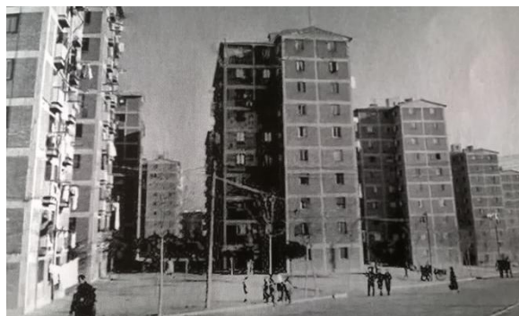
Calle Castillo de Uclés con Hermanos García Noblejas Fuente: “San Blas” (R. Márquez).
