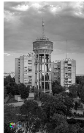
Depósito de agua.
