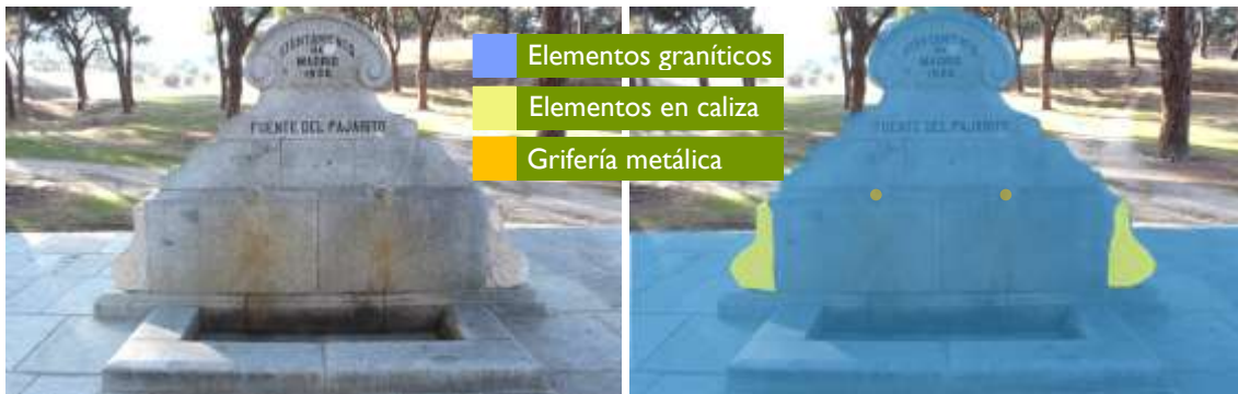
Materiales constructivos de la fuente
