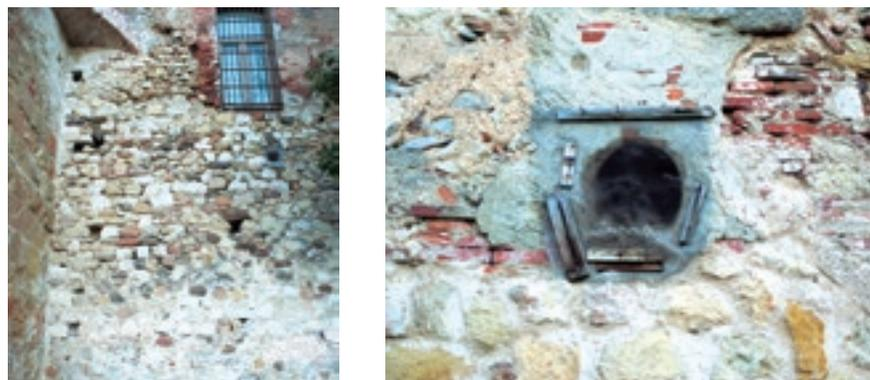
Estado general de muros exteriores. Pérdida de revestimiento. Remates inadecuados.
