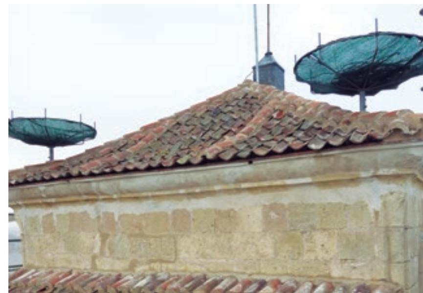
Instalación de estructuras para nido de cigüeña. Se sustentan sobre un poste de hierro anclado a la estructura portante vertical del edificio, evitando su incidencia en tejas y elementos estructurales horizontales de la cubierta. Se observa igualmente huecos dejados en alero para el acceso de vencejos a niales integrados en la edificación. ©Jesús Manzano Pascual, arquitecto.
