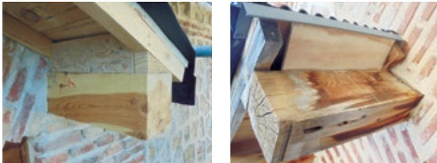
*Se tapa el acceso a dicho apoyo con tabla, dejando una cámara interior de sección triangular, si bien la tabla inferior se hace más corta para permitir el acceso al interior. Este acceso se produce desde la cara externa, sin ser percibida desde la ventana ni provocar molestias al usuario de la celda.*
