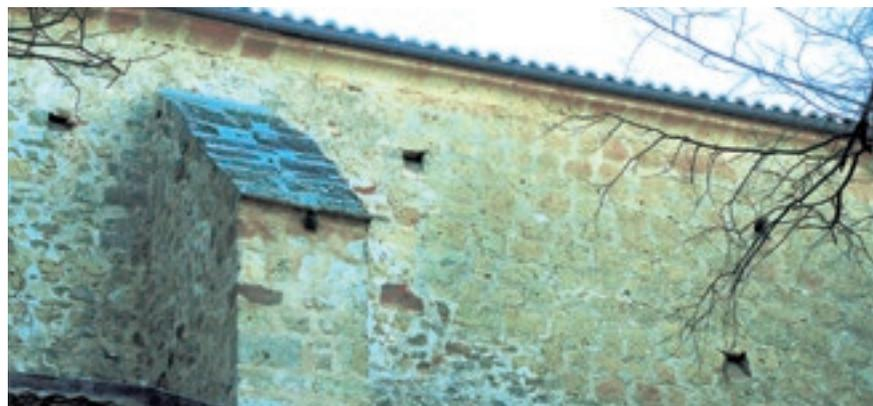
Vista general. El modificado de huecos con mortero tintado oscuro pretende mantener la imagen original y carácter del edificio con mecbinales.
