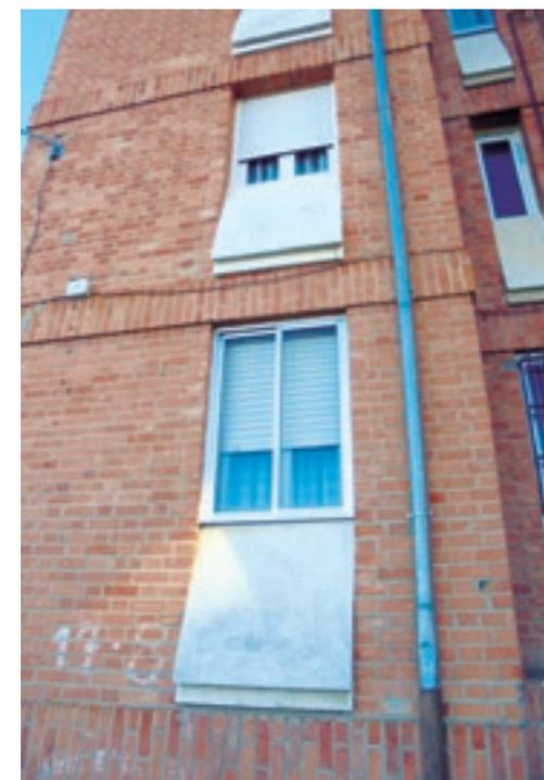
*Detalle de fachada. Véase el poco espesor del muro de cerramiento desde el cerco. El escaso aislamiento proporcionado por la carpintería original ha hecho que algunos vecinos sustituyan la carpintería o instalen doble ventana en su vivienda.*
