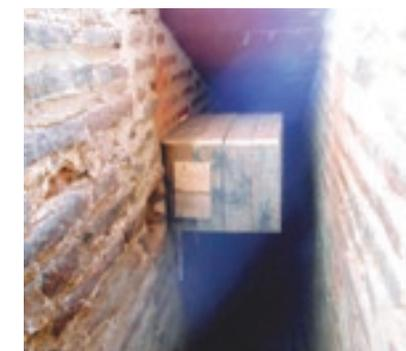
Ejemplo de caja nido de lechuza integrada en edificación, ubicada en cámara de cubierta.
