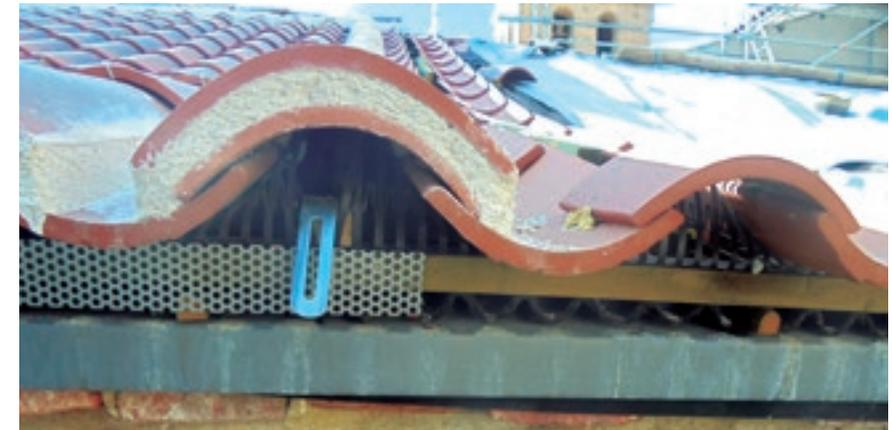
La cámara que forman los rastreles primero y segundo es accesible desde el exterior a través de hueco que genera el anclaje del canalón al aplastar el peine de PVC.
