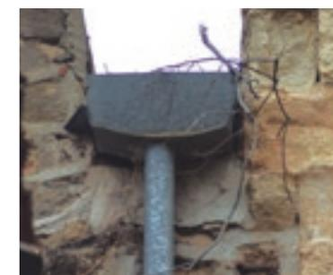
Material de nidos de cigüeña, cuya caída y acumulación puede provocar atasco de lima y cazoleta de recogida de aguas pluviales.
