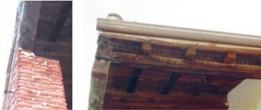
*Pinchos antipaloma en pilastra de ladrillo y elementos horizontales de madera. Porche de cubo oeste. Se observan excrementos y plumas de paloma en pavimento, y sobre las máquinas de climatización*
