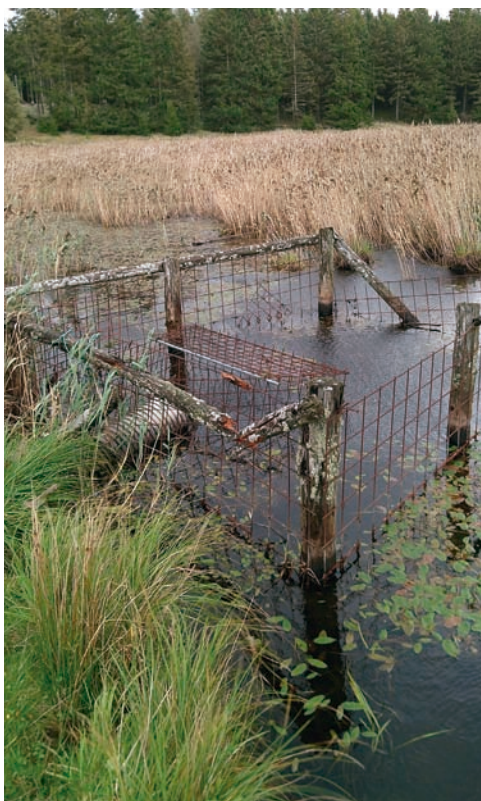
Figura 25. Protección tipo “culvert” con forma rectangular, no techado, situada en Dinamarca. Esta estructura inhibe la actividad de represamiento del castor, permite el flujo de agua a través del dispositivo de flujo de plástico (observable en su parte central izquierda), y así evita la erosión de infraestructuras viarias y/o la inundación de tierras.
