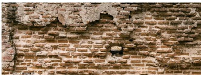
Deterioros en el muro causados por el clima.
