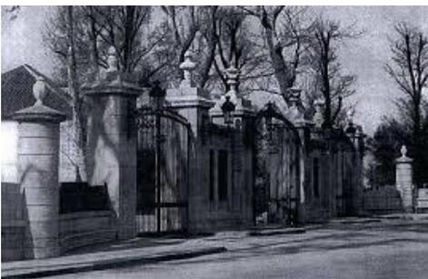
conjunto, adosando a la original dos réplicas de la puerta neoclásica; pero en disposición rectilínea. Cada pilastra presentaba de frente una farola de gran tamaño de hierro fundido para gas; y estaban rematadas por jarrones (en sustitución de los bustos originales). Además, se incorporaron dos
