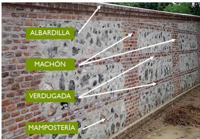
realizada mediante pilares (**machones**) e hiladas horizontales (**verdugadas**) de ladrillos (fabricados en los hornos del Batán) y paños rectangulares (**cajoneras**) de mampostería de piedra de sílex (procedentes de la cantera de Vicálvaro) con mortero de cal. Para protegerla de las inclemencias del
