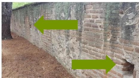
Huecos dejados por los mechinales, característicos de los muros de mampostería. Podrían haber servido para sujetar las maderas con las que se hacía el encofrado o para apoyar los andamios mientras se levantaban hiladas de ladrillos.
