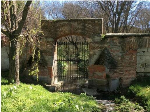
Surge así el sistema de “rejas”, que no fueron si no una especie de construcciones híbridas de puertas y puentes, que estaban cerrados con un conjunto de barrotes metálicos convenientemente enlazados, que daban nombre a todo el conjunto del sistema. Generalmente, estaban realizadas con una
