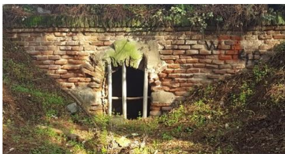
Mina o puentecillo con una canalización, que servía para que las aguas pudieran circular bajo las líneas del antiguo ferrocarril Madrid - Irún
