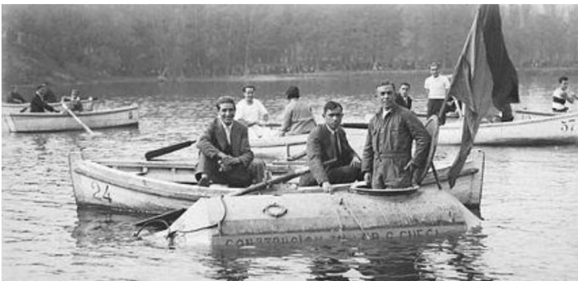
Pruebas del tanque sumergible, que permaneció con su piloto cerca de cinco horas y media bajo las aguas de El Lago.
